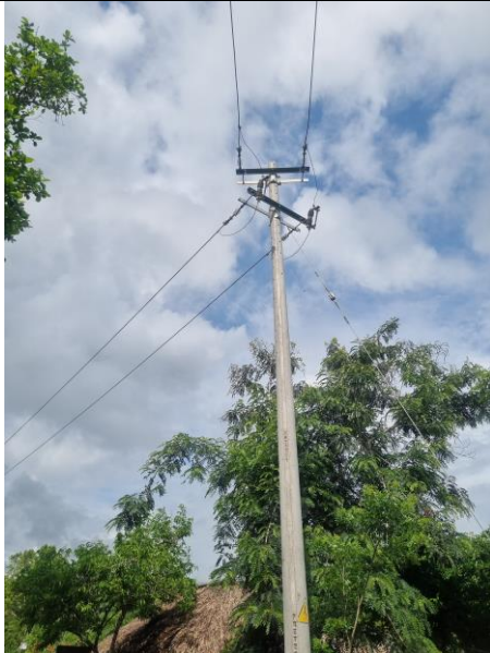
8°45'26.6"N 76°15'38.2"W Estructura inicio tramo 2 AAAC 123
