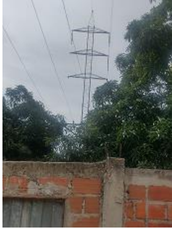
Zona de podas de mantenimiento Línea Ternera Gambote Fuente: Visita SSPD
