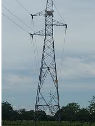
Vista de la línea Tierra Alta Sinú Fuente: Visita SSPD
