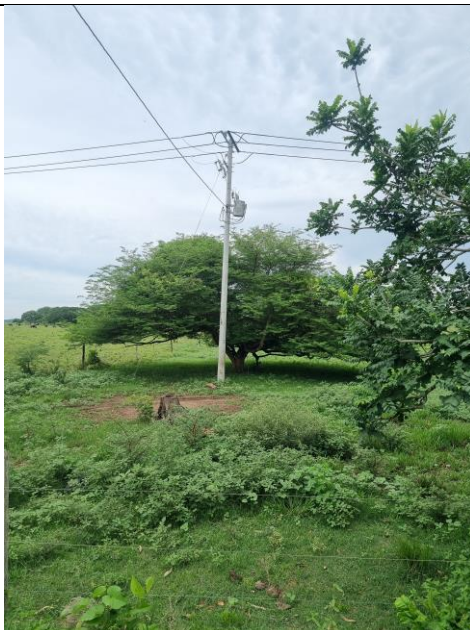
Estructura intermedia aproximadamente a 4 kilómetros del inicio.
