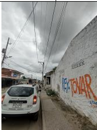
Redes de M.T y B.T Olaya Herrera – sector progreso Fuente: Visita SSPD
