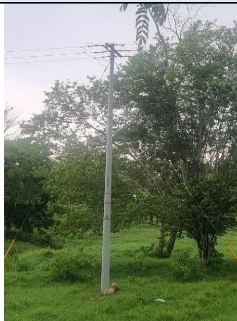
8°38'23.5"N 75°22'50.6"W, Estructura final tramo 3 de 1,4 kilómetros.
