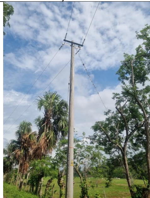
Estructura intermedia, transformador y red trenzada baja tensión.
