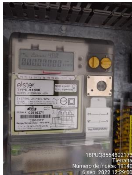
Reposición Medidor N3- TIERRALTA-CORDOBA NORTE Fuente: AFINIA
