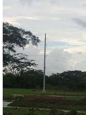
Cambio de estructura Línea Ternera Gambote Fuente: Visita SSPD
