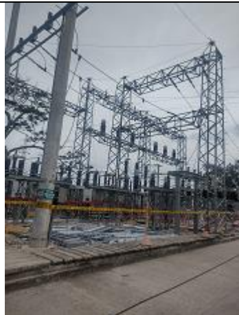
Avance constructivo S/E Gambote Fuente: Visita SSPD
