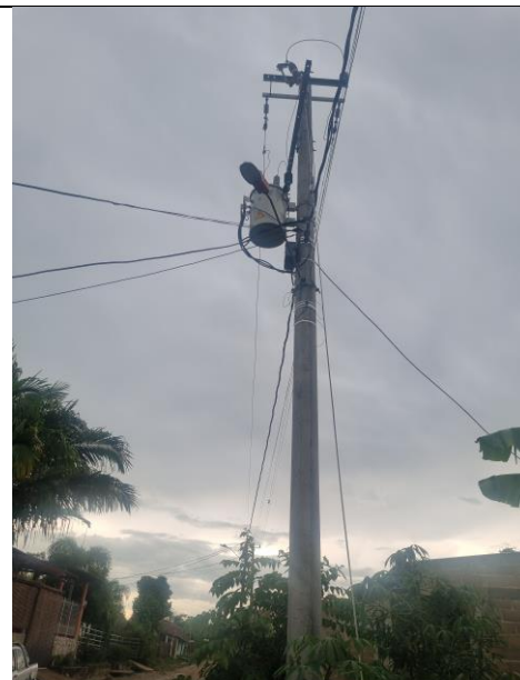
8°38'37.8"N 75°21'51.9"W, Estructura final tramo 4, 190 metros
