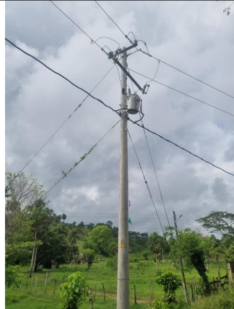
Estructura intermedia, transformador y red trenzada baja tensión.
