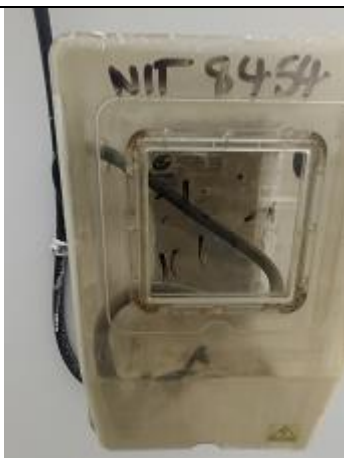
Caja para Display sin equipo Mocari Fuente: Visita SSPD
