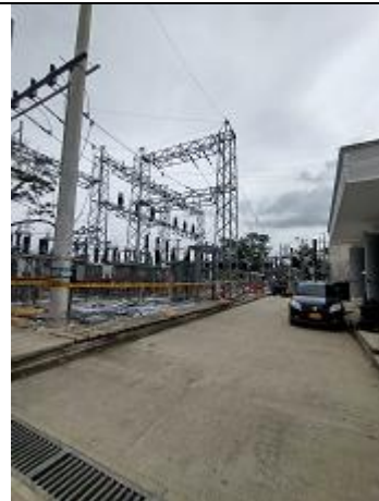
Avance constructivo S/E Gambote Fuente: Visita SSPD
