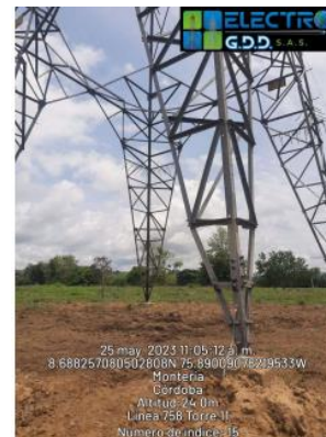
Fotografía remitida vía WhatsApp corrección torre 11 Fuente: AFINIA
