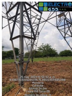
Fotografía remitida vía WhatsApp corrección torre 9 Fuente: AFINIA
