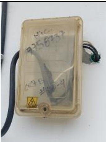
Caja para Display sin equipo Villa Cielo Fuente: Visita SSPD
