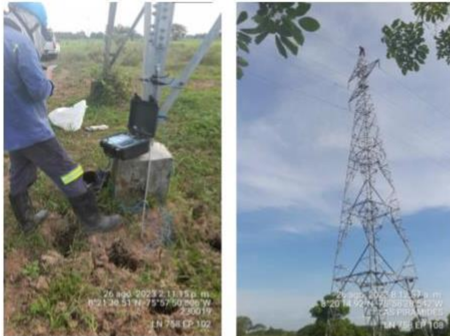
Reposición de sistemas de puesta a tierra In758 Río Sinú – Tierra Alta 110 kV
