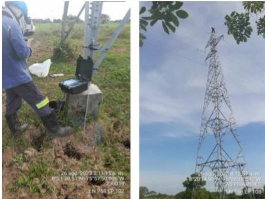
Reposición de sistemas de puesta a tierra LN758 Río Sinú – Tierra Alta 110 kV
