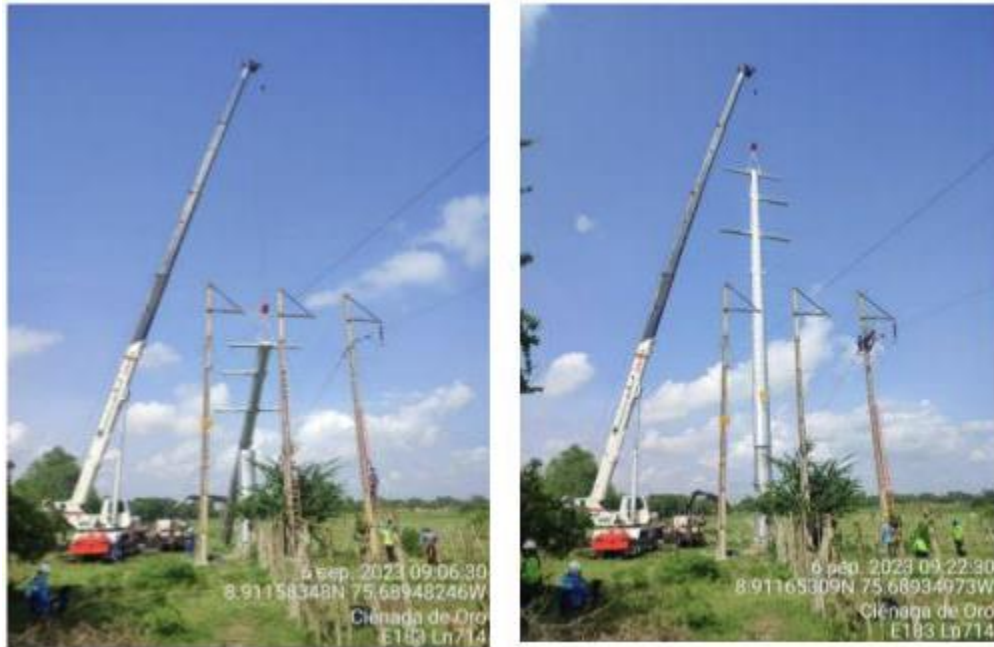
Reposición de Estructura LN714 Chinú-Cereté 110 kV
