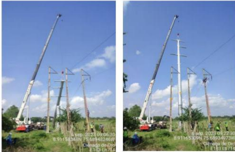
Reposición de Estructura LN714 Chinú-Cereté 110 kV
