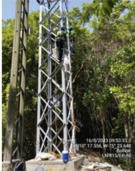
Reposición de estructura LN615 Ternera – Gambote 66 kV
