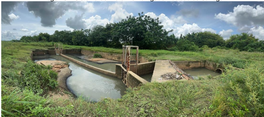
Estructura de entrada al sistema, cribado y desarenador
