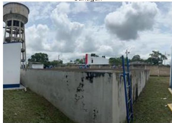
Tanque semienterrado No. 2 – 1.000 m 3
