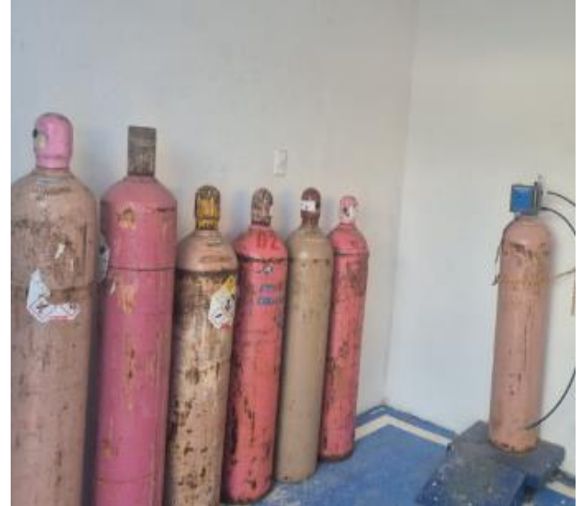
Cilindros para cloración de agua
