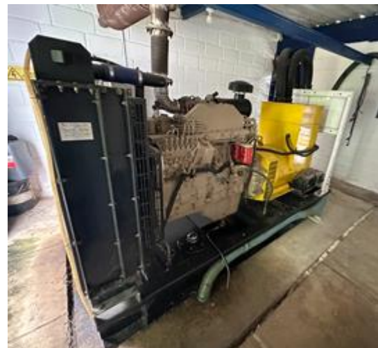
Planta de respaldo de energía
