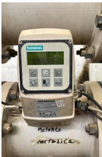
Macromedidor sector Metálico
