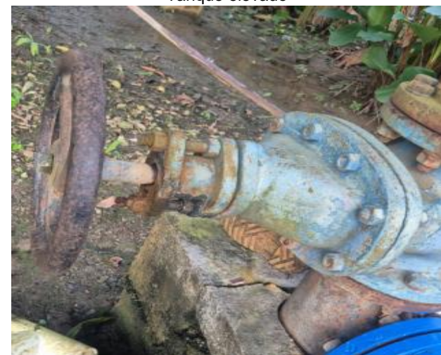
Válvula línea de impulsión
