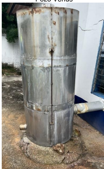
Sistema de manejo de olores EBAR
