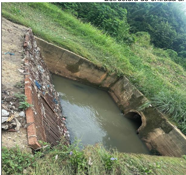
Colector y cribado
