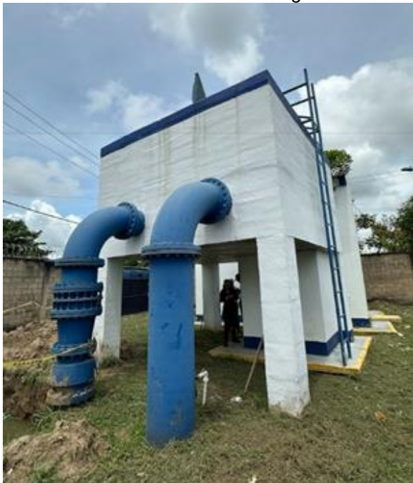
Cámara de aquietamiento
