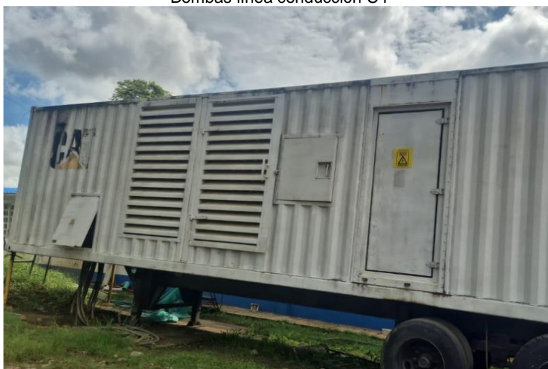
Planta de emergencia Diésel
