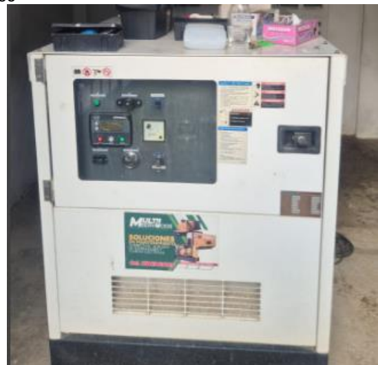
Planta de emergencia Diésel
