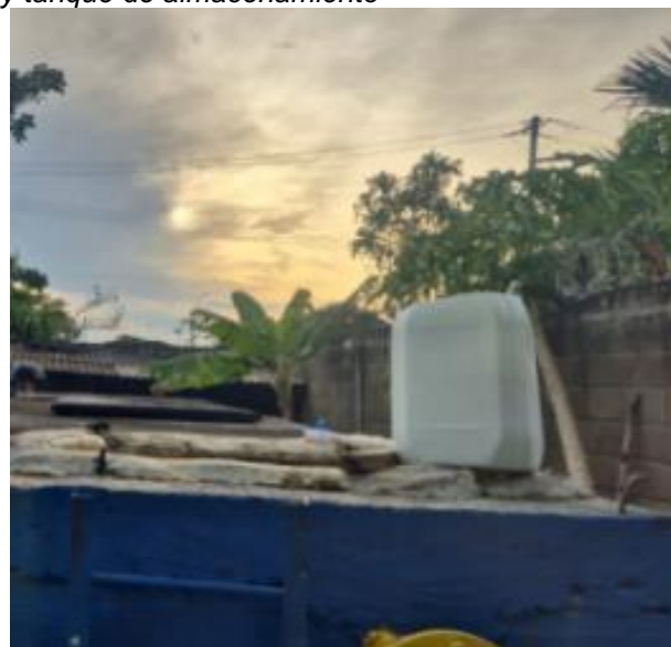
Dosificación de cloro directa a tanque
