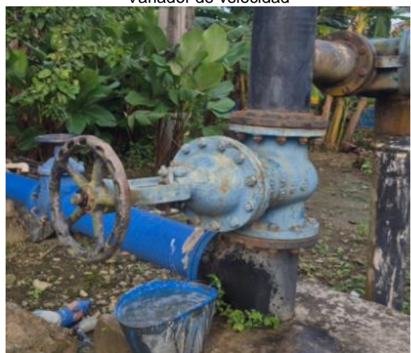
Línea de impulsión a tanque elevado
