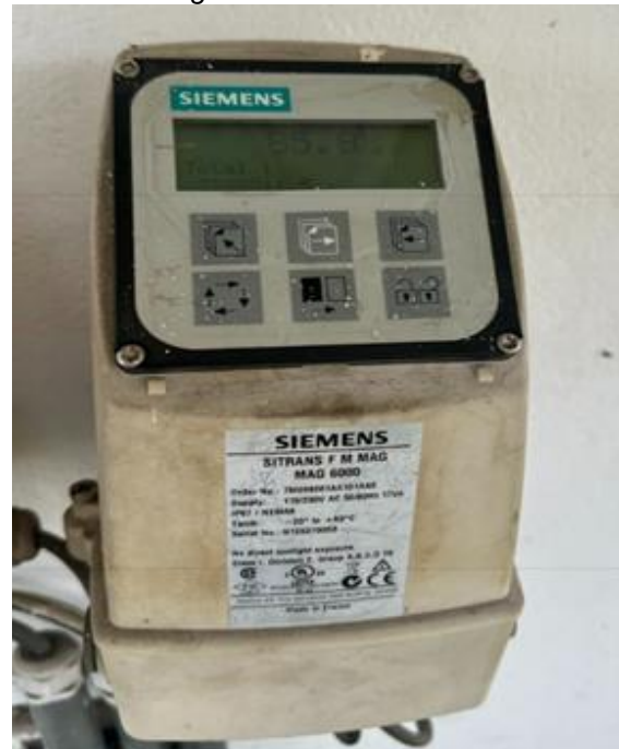
Macromedidor línea conducción Ciénaga de Oro - Sahagún
