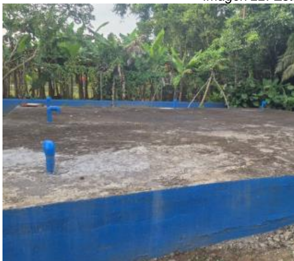
Tanque semienterrado
