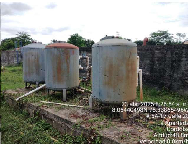
Sistema de filtración (fuera de servicio).
