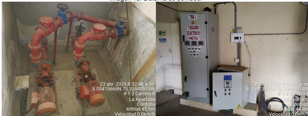
Bombas centrífugas.
