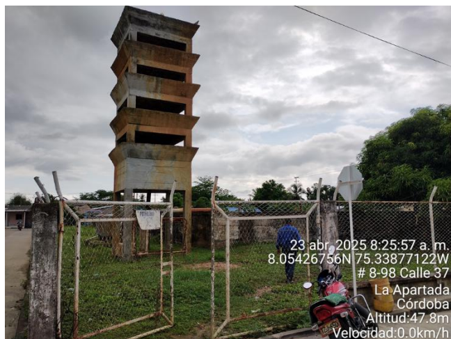
Torre de aireación (fuera de servicio).
