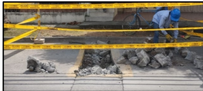
Fotografía No. 7. Demolicion de area con hundimiento
