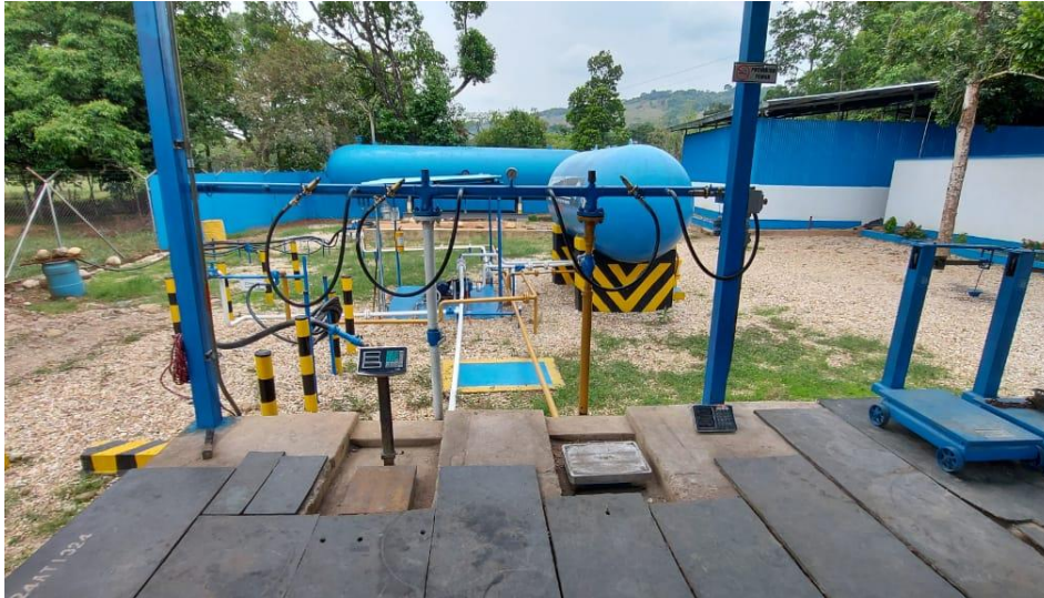
Imagen N°1. Ubicación Planta COMERCIALIZADORA G.L.P. DEL ORIENTE S.A.S. E.S.P.
