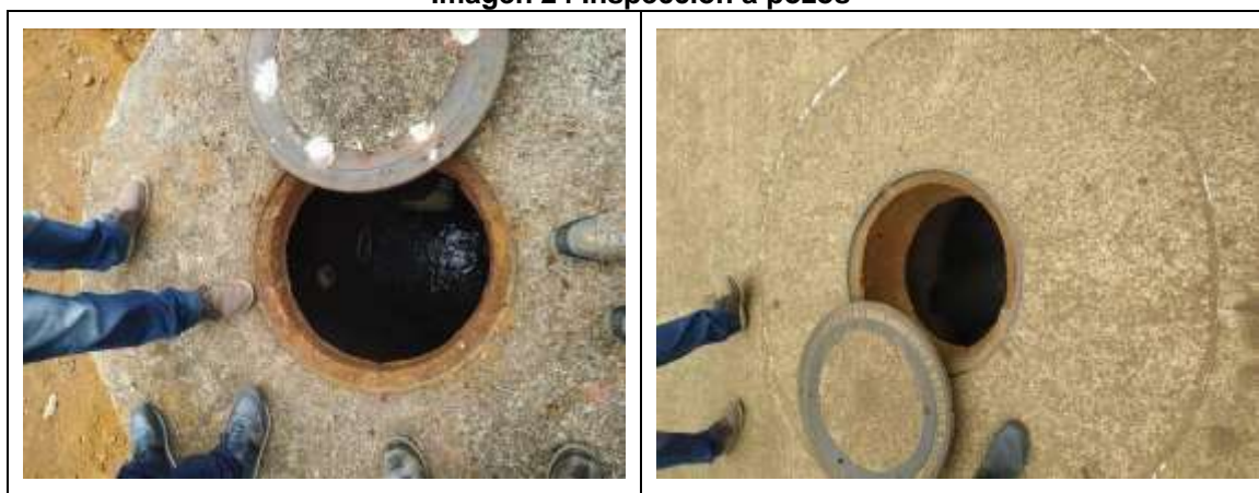
Imagen 24 Inspección a pozos
