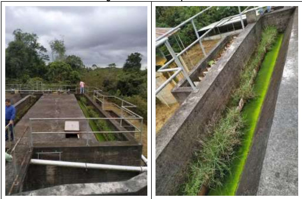
Imagen 30 PTAR municipio Mitú
