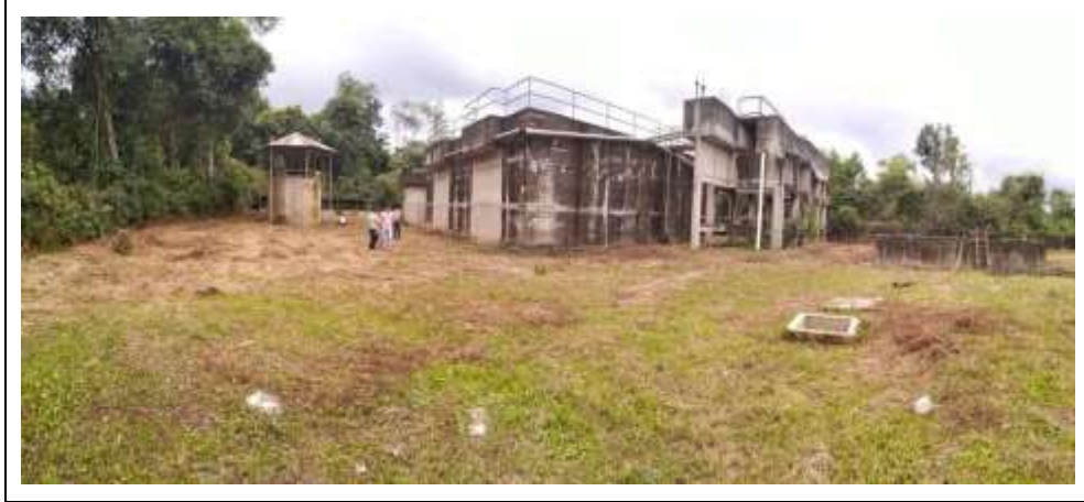
Imagen 26 Vista panorámica PTAR
