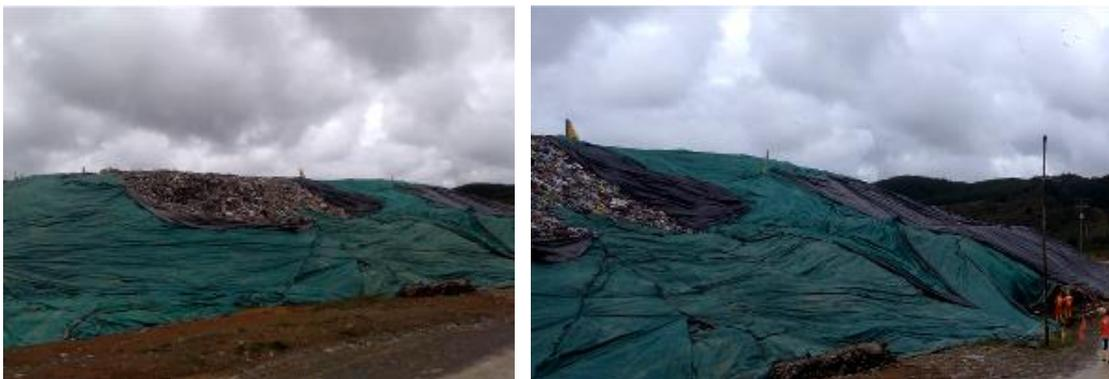
Imagen 31. Cubrimiento de residuos Relleno Sanitario Los Picachos
