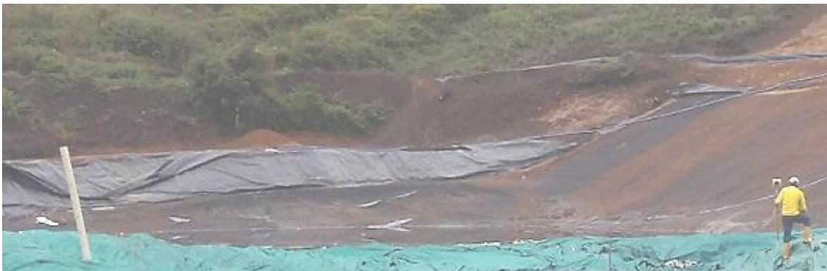
Imagen 39. Vaso fase II sección B con acumulación de líquido.
