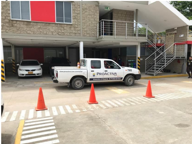
Imagen 2918. Acceso. Base de operaciones PROACTIVA ORIENTE S.A. E.S.P.
