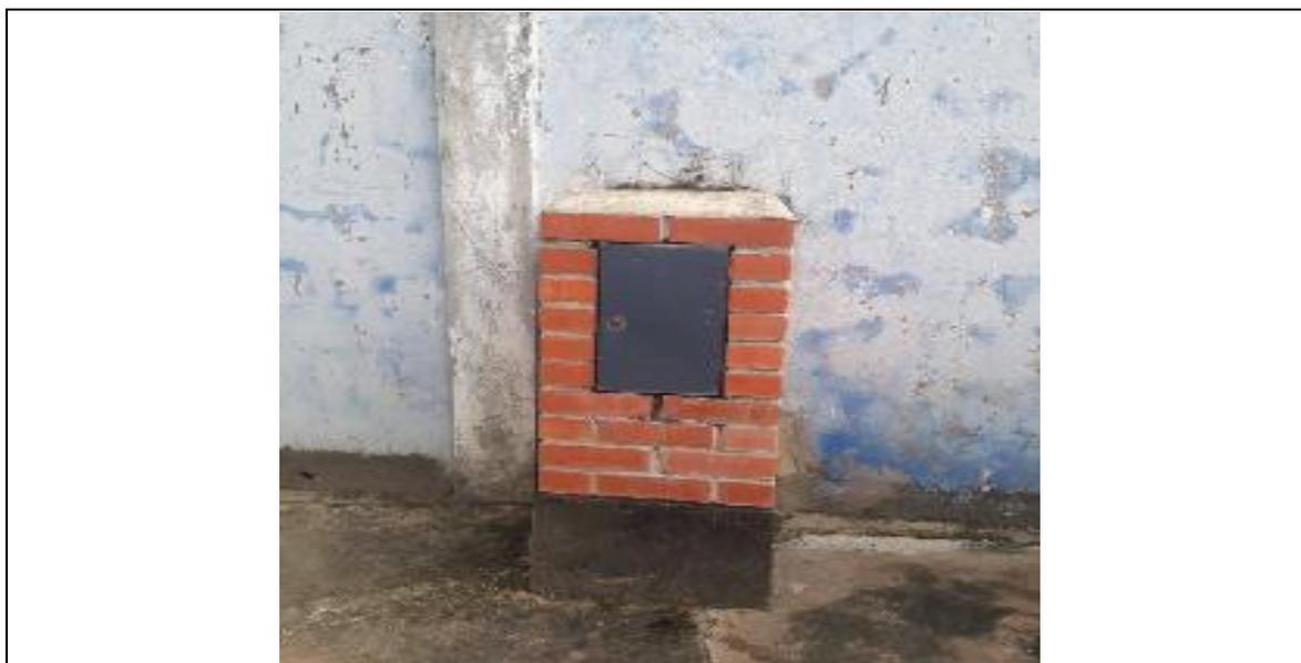
Ilustración 21 Caseta Punto de muestreo 1- Salida tanque de almacenamiento
