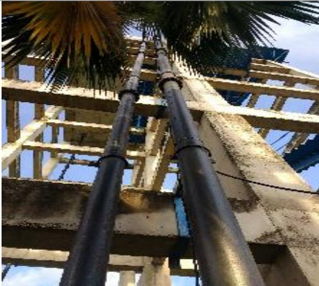
Ilustración 12 Tubería de paso Tanque cuadrado al cilíndrico
