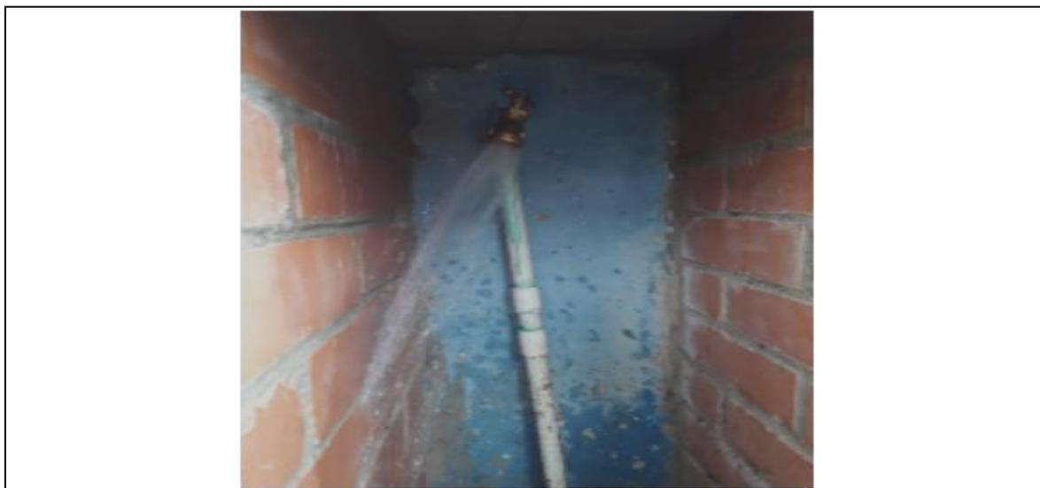
Punto 2: Se observa en buen estado, cuenta con caseta, cerradura. No se pudo verificar funcionamiento (5:00 p.m.) fuera del horario de prestación. No se cuenta con manómetro, no se realiza medición de presiones.
