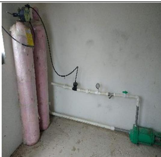
**Situación encontrada en visita:** Sistema de cloración en operación, no hay macromedición. No se cuenta con laboratorio, ni equipo para el análisis de características básicas, por tanto, no se realiza este tipo de control. No se lleva bitácora de operación, ni registro de caudales
