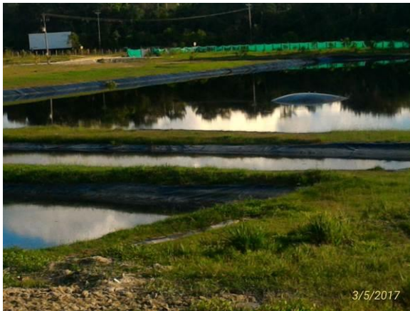
Foto 59. Sistema de Tratamiento de lixiviados
