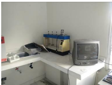
Foto 28. Equipo ensayo de jarras
