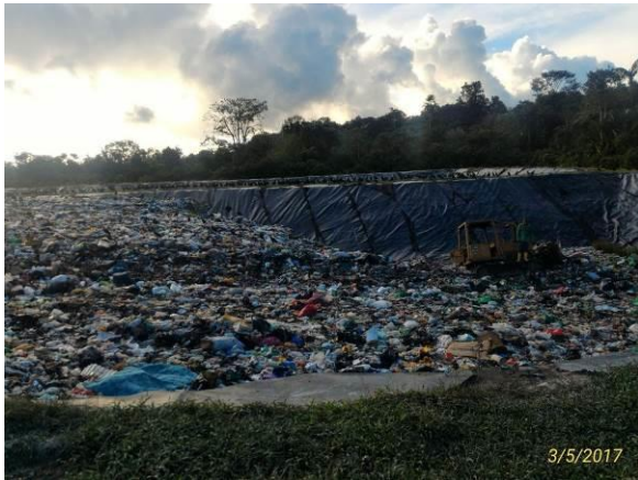
Foto 55. Celda 5. En operación. Arrastre de residuos lado opuesto celda
