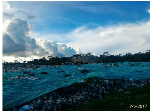
Foto 54. Frente de trabajo- compactación
