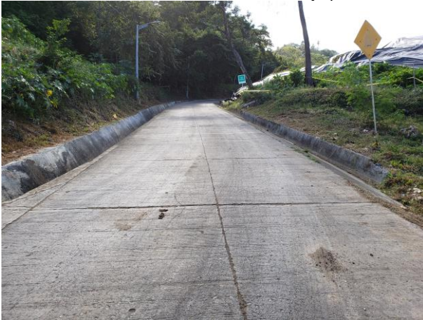
Foto 2. Vía interna al frente de trabajo parte 1.
