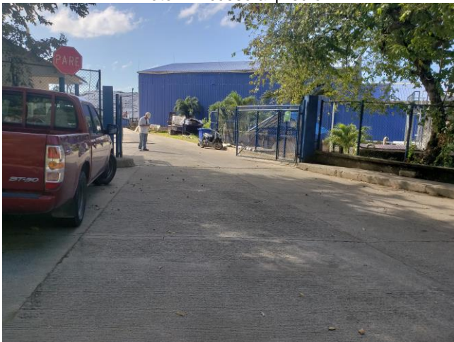
Fuente. Registro fotográfico SSPD – Visita enero 2019
