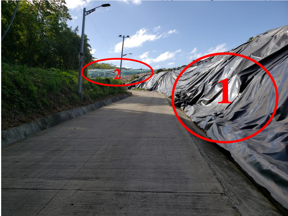
Foto 11. Cubrimiento geomembrana en zona 4 (1) y material negro verde zona 5 (2).
