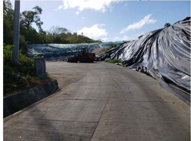
Foto 3. Vía interna al frente de trabajo parte 2.
