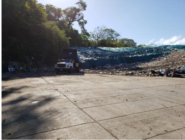
Foto 10. Vehículo realizando descarga de residuos en el frente de trabajo
