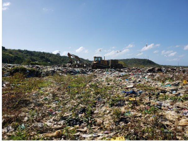
Foto 9. Buldócer y retroexcavadora realizando acomodación y disgregación
