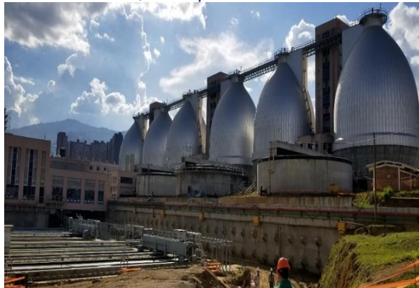
Ilustración 4. Vista general PTAR Aguas Claras. Bello, Antioquia año 2018.
