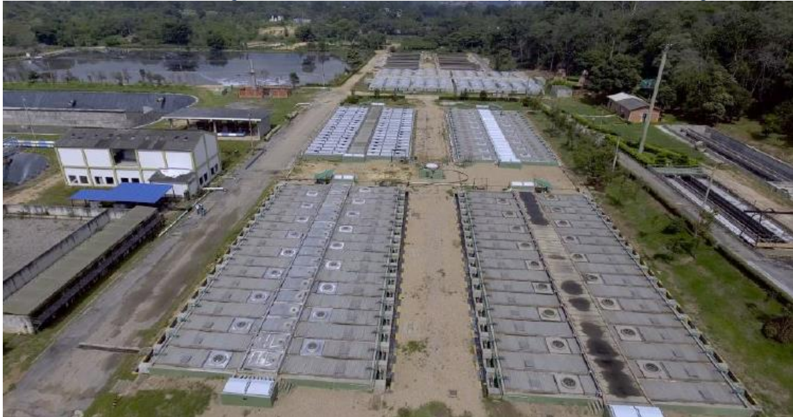
Ilustración 5. Vista general PTAR Ríofrío. Área Metropolitana de Bucaramanga.
