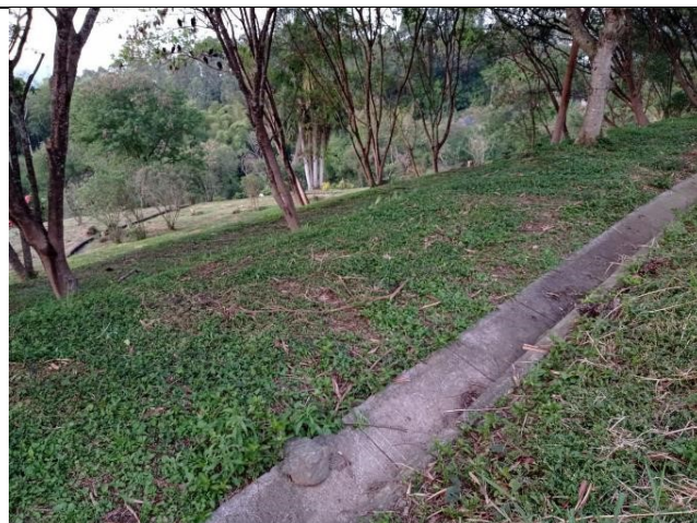
Canales de aguas lluvias en zonas clausuradas
