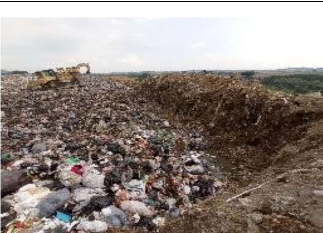
Empozamiento de lixiviados en frente de trabajo
