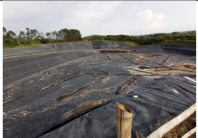
Vaso 8 constuido al momento de la visita
