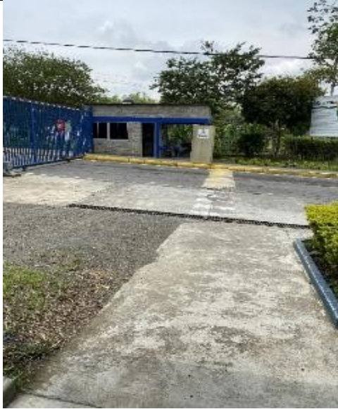
Control de ingreso, porteria y puerta
