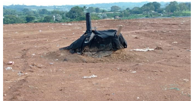
Chimeneas en zonas con cobertura intermedia
