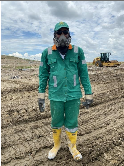
Elementos de protección personal de los operarios en el relleno sanitario.
