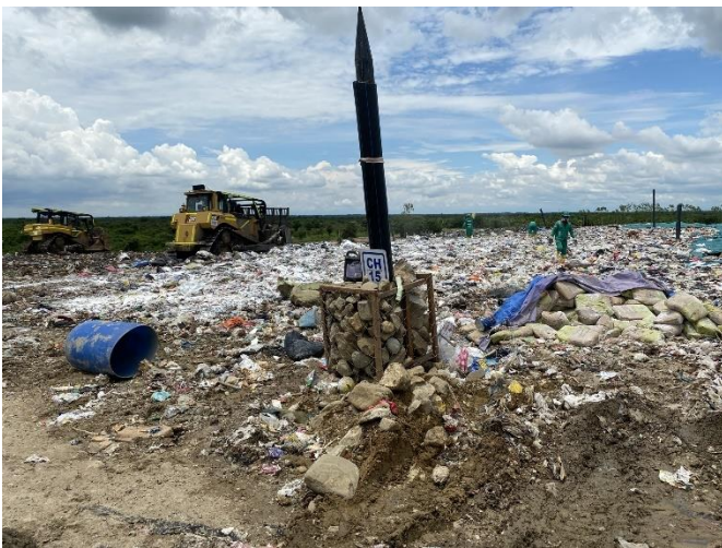
Canales de conducción de lixiviados a la planta de tratamiento
