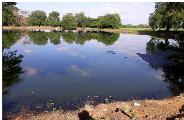
Imagen 19. Laguna de maduración – Valencia, Córdoba
