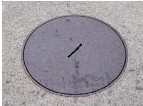
Imagen 13. Tapas de alcantarillado en Valencia - Córdoba
