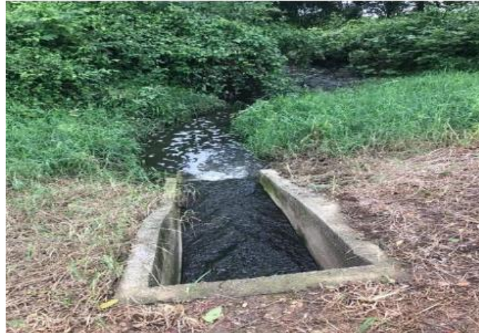
Imagen 20. Estructura de salida – Valencia, Córdoba
