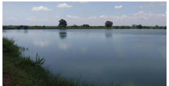
Laguna de oxidación
