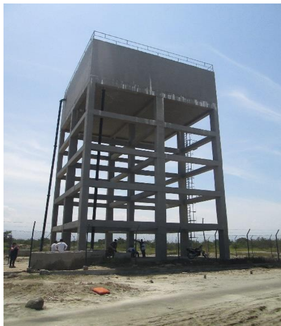
Fotografía 5 Tanque elevado de almacenamiento Tasajera.
