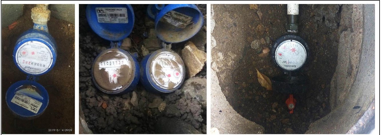
Fuente: Visita de inspección
