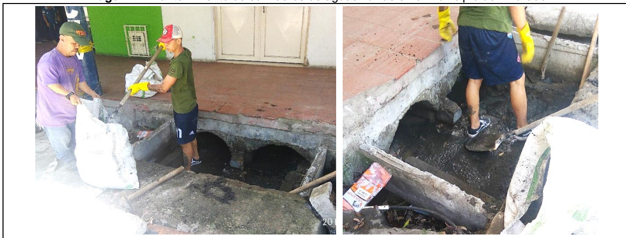
Imagen 17. Mantenimiento de sumideros de aguas lluvias en el municipio de Alvarado.
