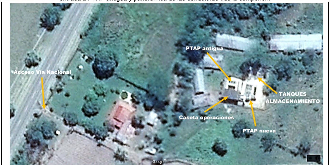
Imagen 8. PTAP del acueducto de Alvarado, Tolima. Se ilustra su localización, cerramiento perimetral, valla informativa (no corresponde a PTAP, sino PTAR), estación de cloración, tramo final de aducción, vertedero de entrada a PTAP antigua y panorámica de las estructuras que la componen.
