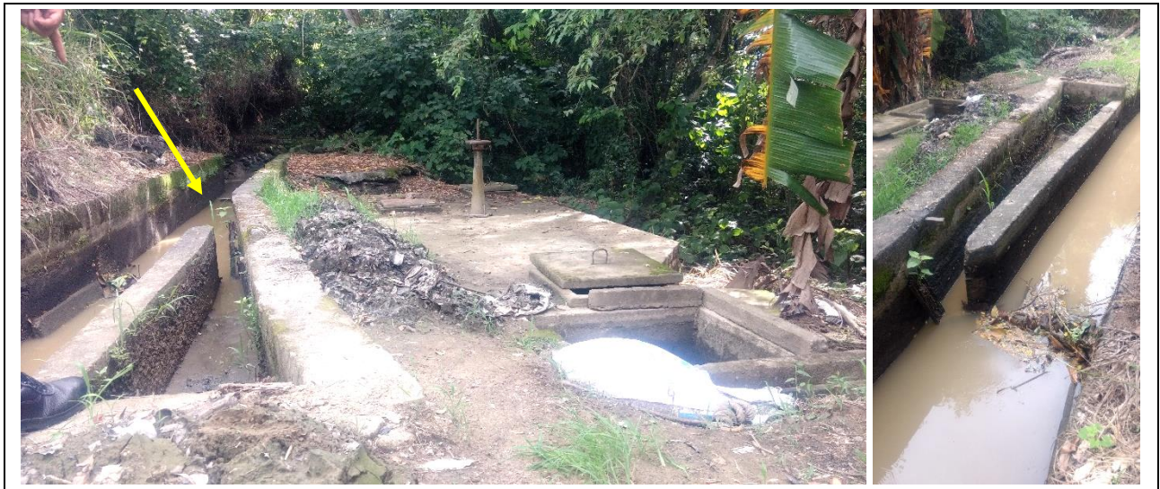
Imagen 5. Bocatoma La Albita (arriba) y El Puente (abajo), en el predio La Libertad de Alvarado, Tolima. Se ilustra su localización, la ausencia de valla informativa, su estructura y estructuras desarenadoras adyacentes.
