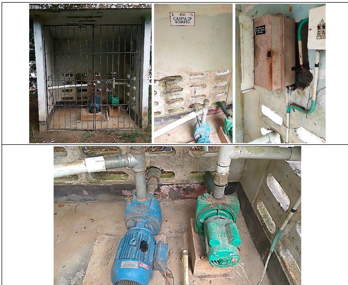
Fuente: Visita de inspección
