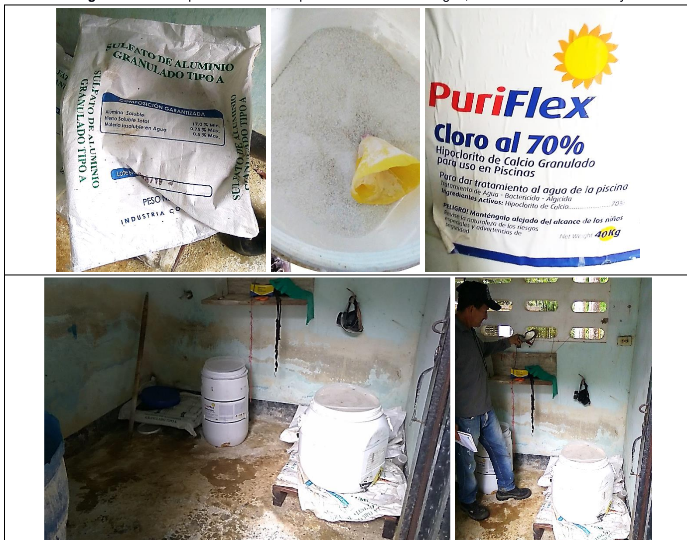
Fuente: Visita de inspección
