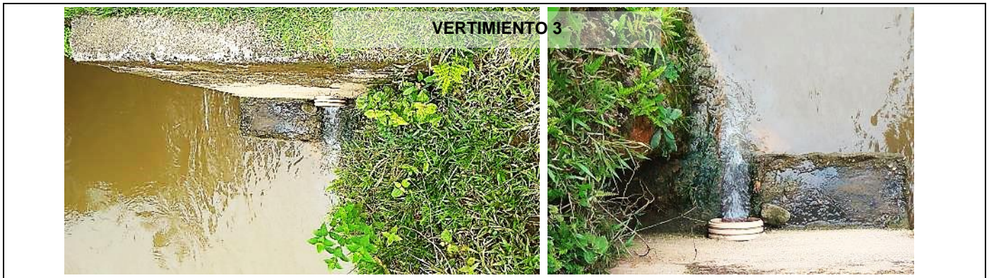
Fuente: Visita de inspección
