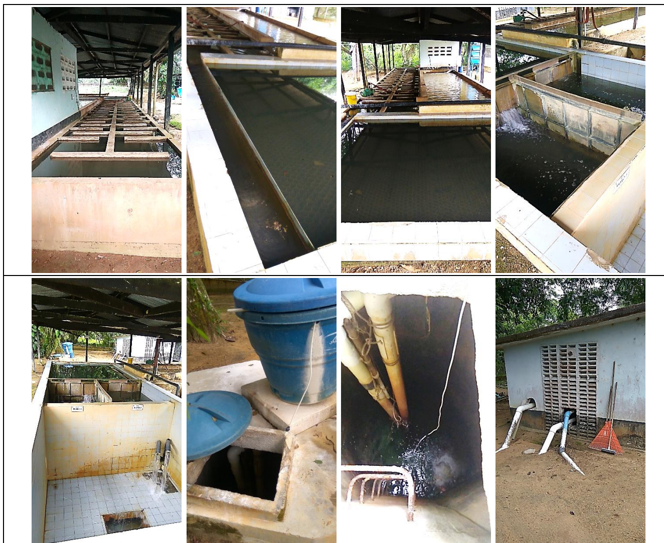
Fuente: Visita de inspección
