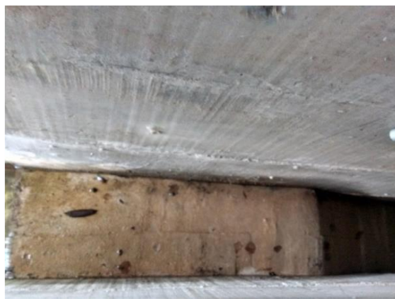
Mezcla rápida y medición de caudal por vertedero
