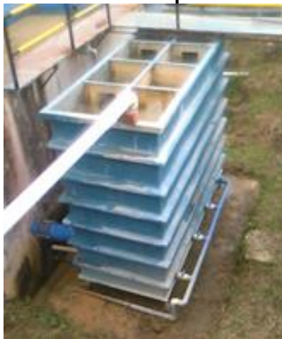
Floculador planta compacta
