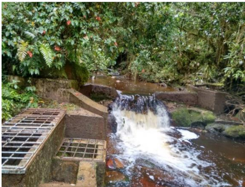
Imagen 10. Captación sobre la Quebrada La Chorrera
