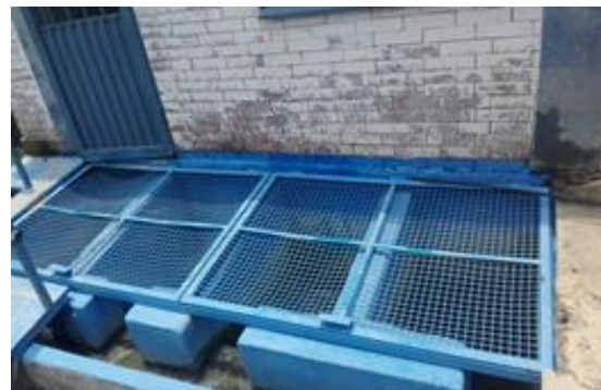
Filtro planta convencional
