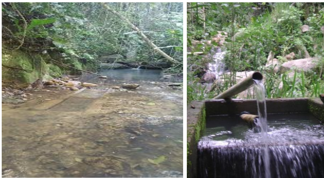
Imagen 9. Captación y tanque de cribado sobre la Quebrada La Grande
