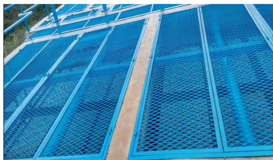
Sedimentadores de alta tasa
