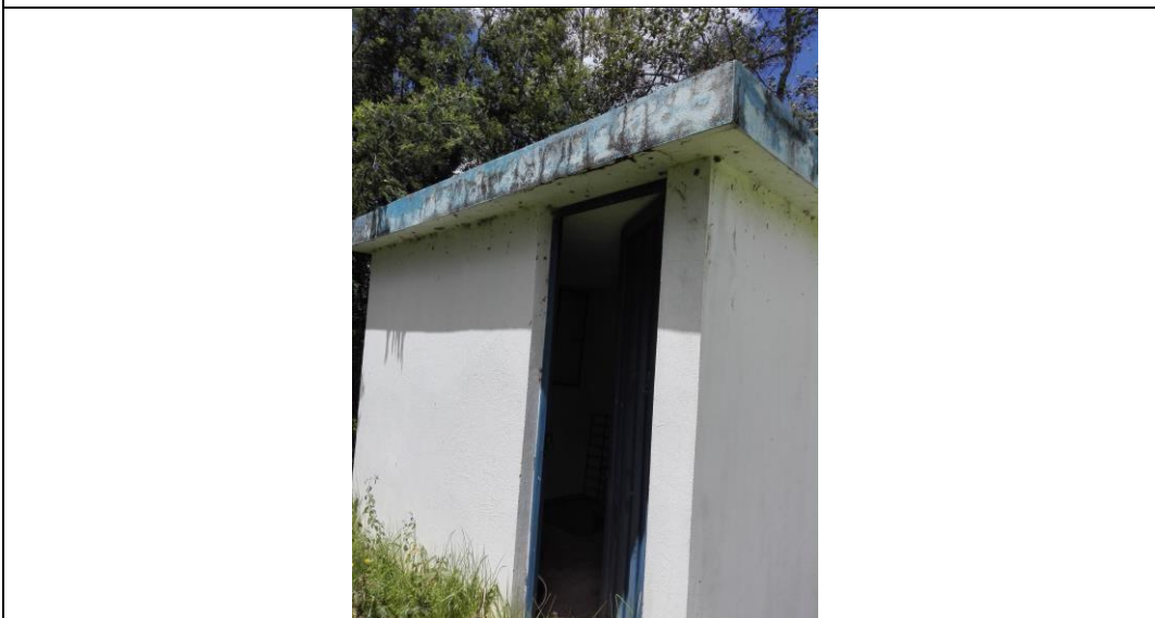
FOTO 15. CASETA QUE FUE CONSTRUIDA PARA REALIZAR PROCESO DE DESINFECCIÓN A LA SALIDA DE LA ÚLTIMA LAGUNA
