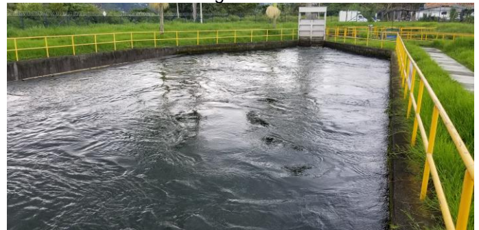
Tanque de carga
