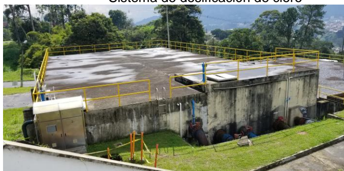
Tanque de contacto de cloro
