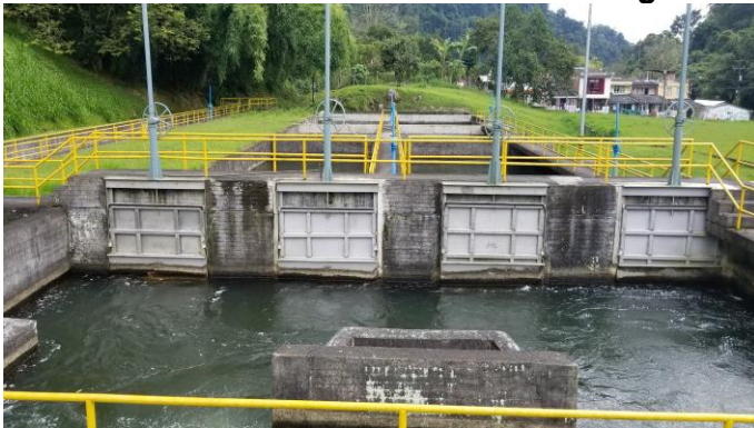
Cámara de distribución de caudales
