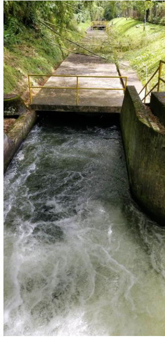
Canal de aducción a la salida de los desarenadores
