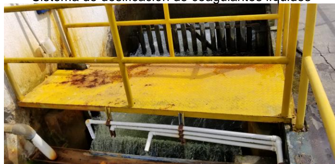
Aplicación de coagulante
