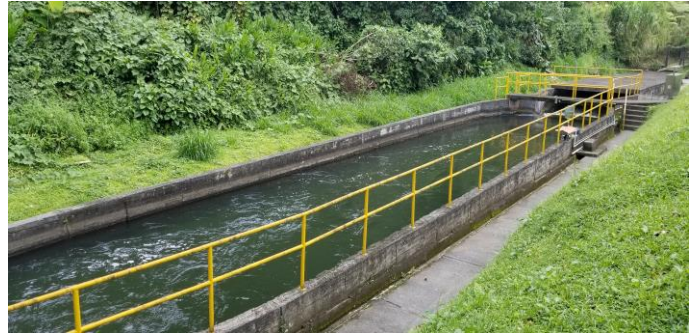
Canal de aducción
