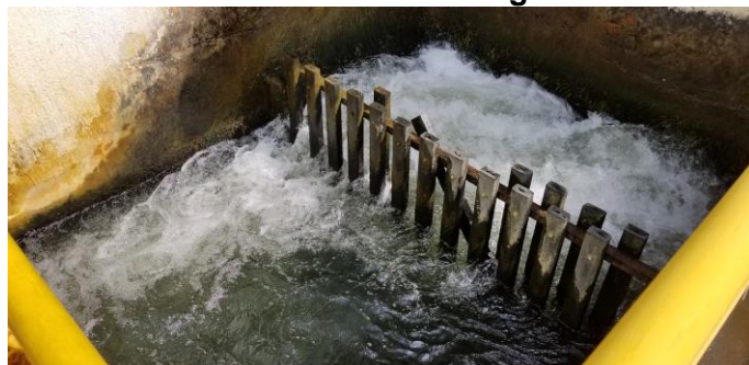
Estructura de entrada
