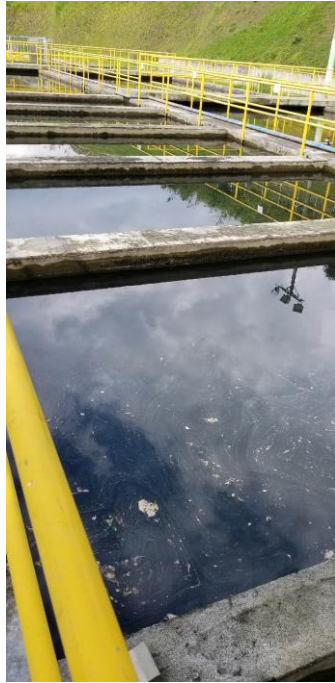
Floculadores mecánicos de eje horizontal
