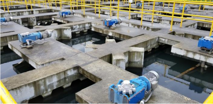
Floculadores mecánicos de eje vertical
