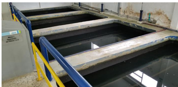
Floculadores mecánicos de eje horizontal
