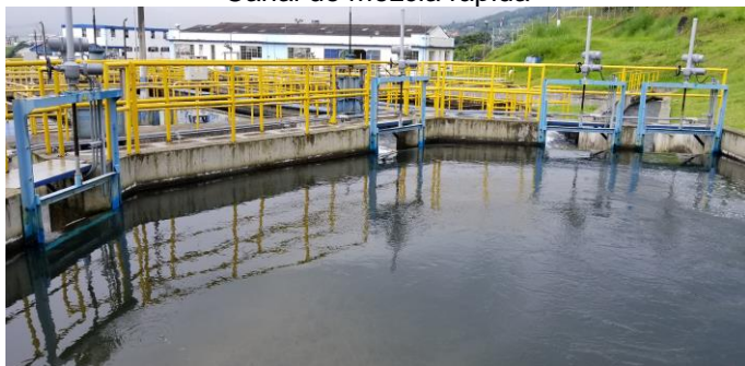
Cámara de distribución de caudales
