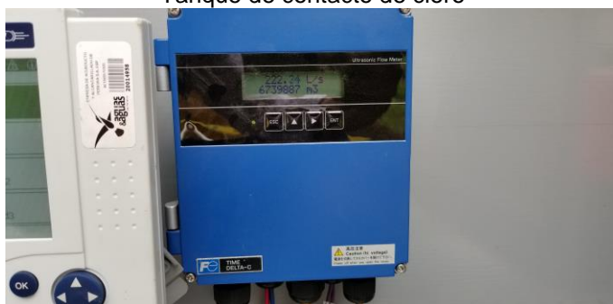
Medición de caudal a la salida de la planta
