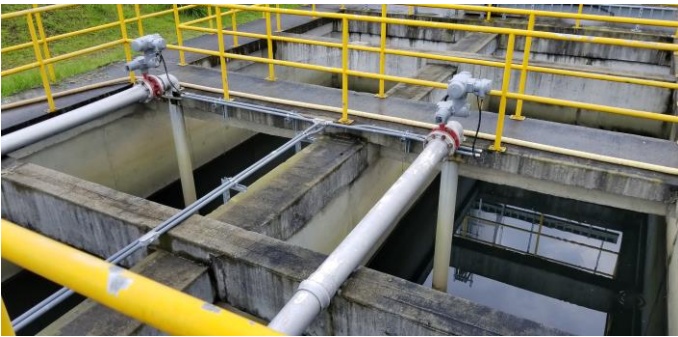
Floculadores mecánicos de eje vertical
