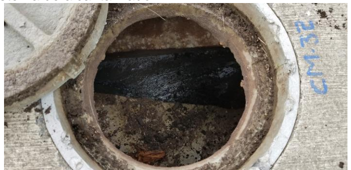
Cámara de inspección sector "Corales"
