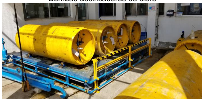
Tanques de cloro gaseoso
