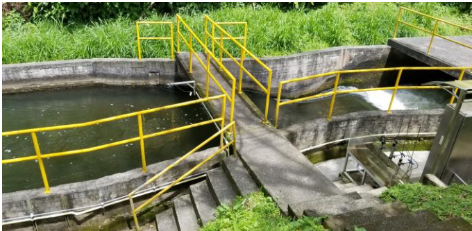
Canal de aducción a la salida de los desarenadores
