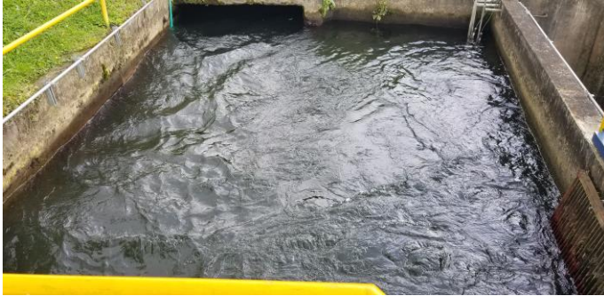
Estructura de entrada
