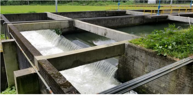
Salida de los desarenadores
