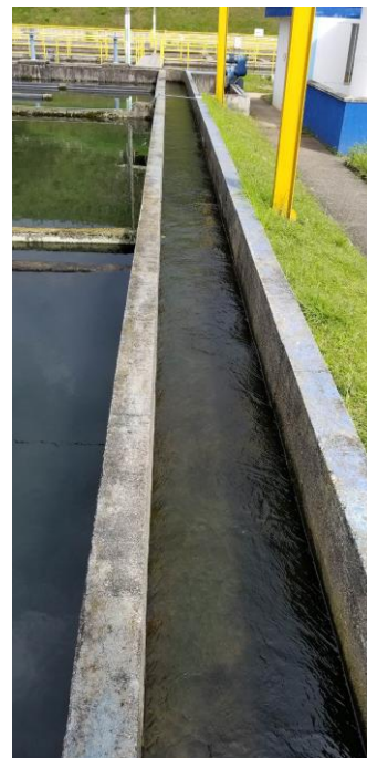
Canal de entrada a la planta
