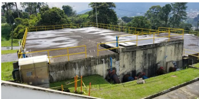
Tanque de contacto de cloro
