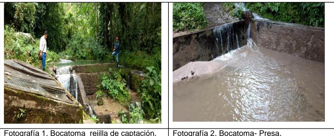
**Caudal captado:** Acorde con información del Plan Maestro de Acueducto la evaluación hidráulica de la rejilla de captación se concluye que tiene una capacidad estimada de 121.6 lt/s. Su estado permite señalar que tiene las condiciones estructurales para seguir operando sin inconvenientes técnicos, no obstante, el documento suministrado será objeto de análisis por la Superintendencia para determinar dicho valor.
