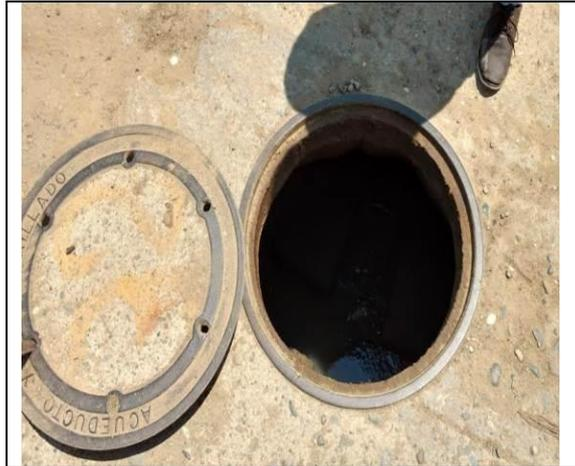
Fotografía 20. Verificación pozos de inspección
