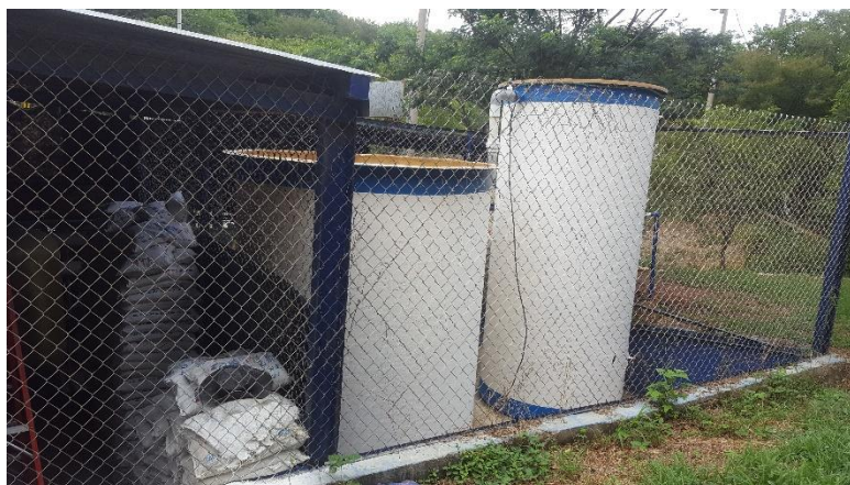
Ilustración 35. Tratamiento primario anaerobio
