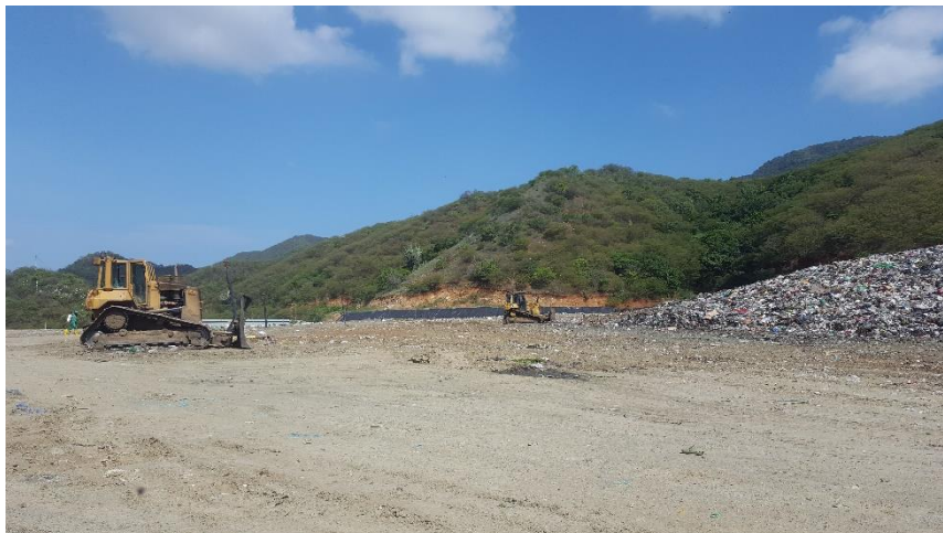
Ilustración 27. Maquinaria presente en el frente de trabajo.
