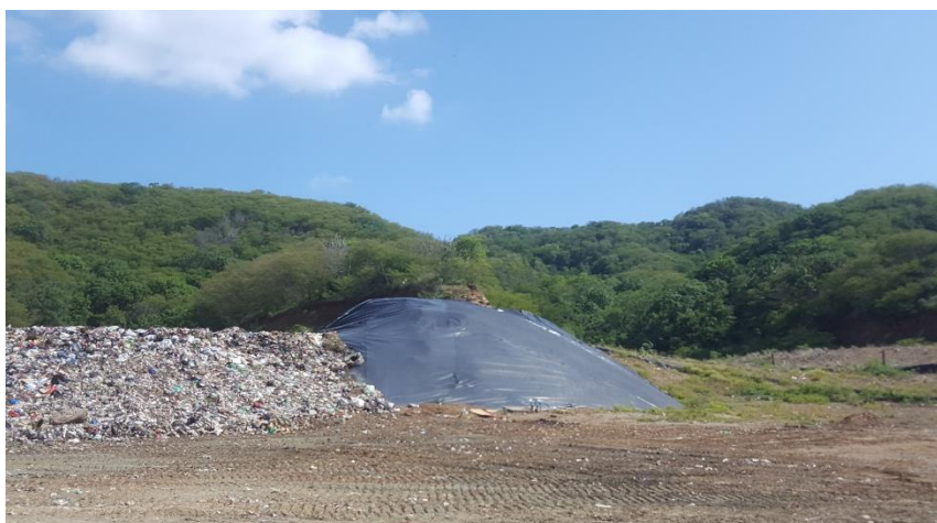
Ilustración 29. Cobertura diaria con geomembrana negra
