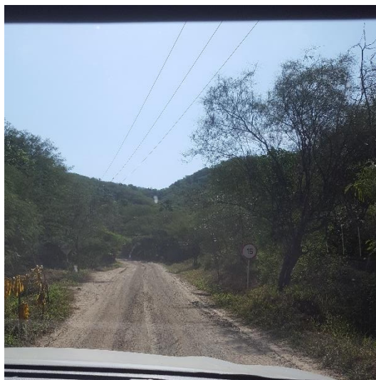
Ilustración 19. Vía interna del relleno
