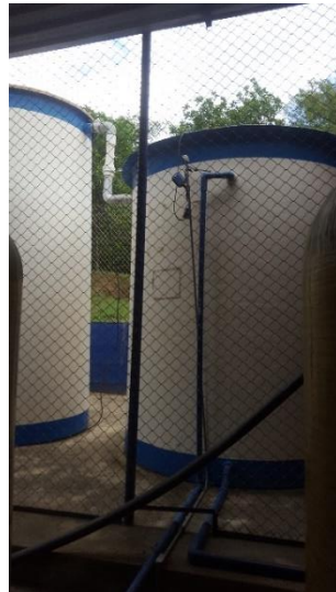
Ilustración 37. Tanque oxigenación
