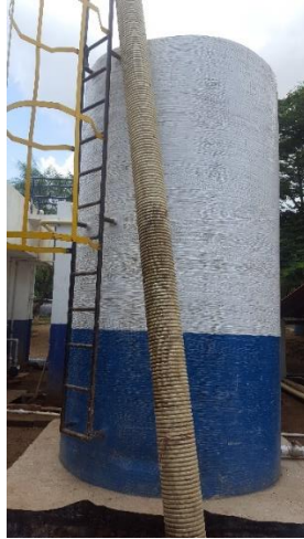
Ilustración 36. Sedimentador
