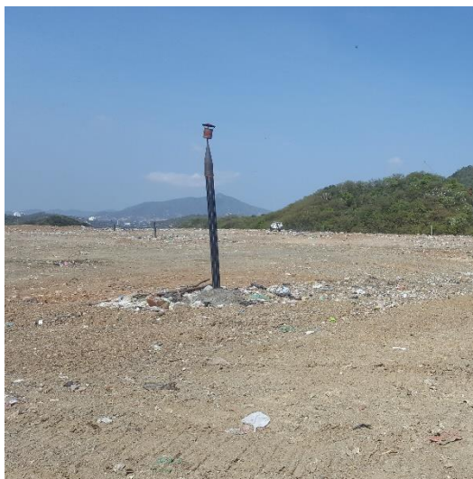
Ilustración 43. Chimenea de quema de biogás
