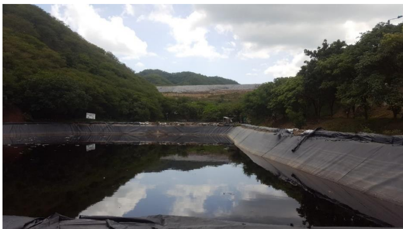
Ilustración 34. Piscina de almacenamiento
