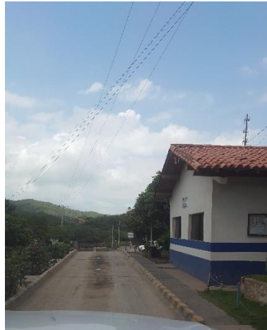
Ilustración 22. Báscula y caseta de pesaje
