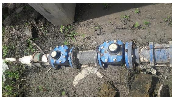
Tubería de ingreso de 6 pulgadas, con macromedidor instalado fuera de operación
