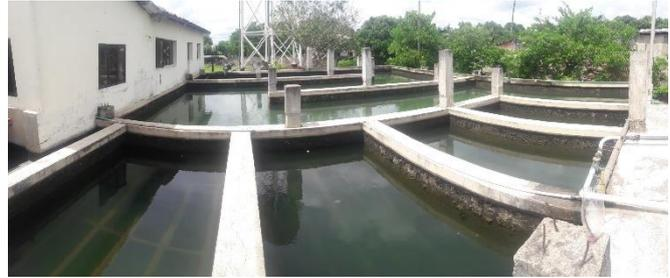
Tanque de agua filtrada, el cual antiguamente era un sedimentador tipo serpelein, y que ahora se utiliza como almacenamiento para el agua filtrada.
