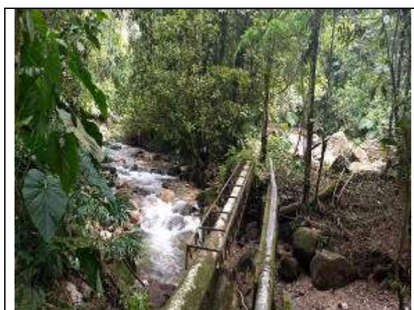
Foto 5. Redes de aducción
