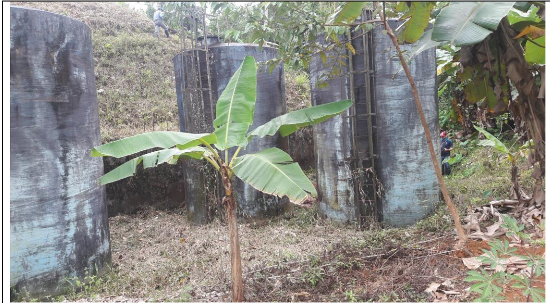
Fotografía 8 Tanques de Almacenamiento
