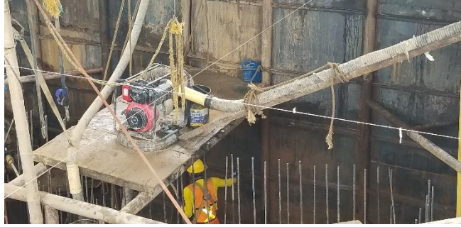
Obras de ampliación.
