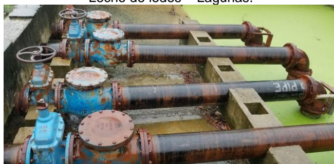
Bombeo al punto de vertimiento.
