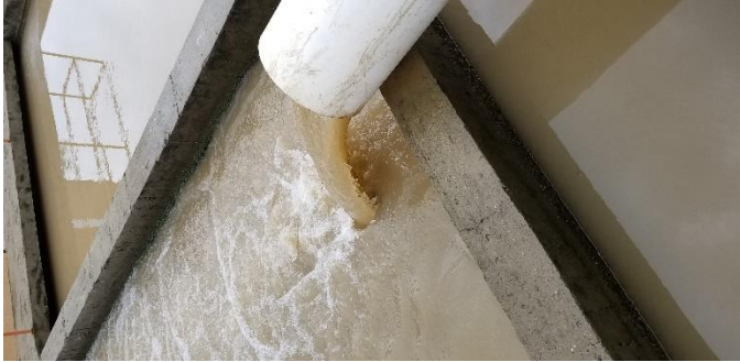
Estructura de entrada – Río Arauca.
