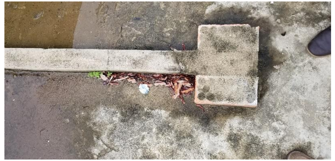
Punto de aplicación del cloro gaseoso.
