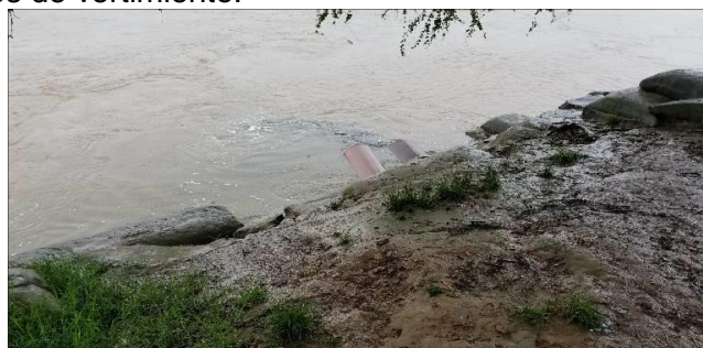
b) Tubería de vertimiento por gravedad.
