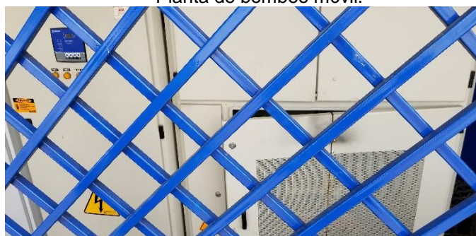
Planta de energía alterna.
