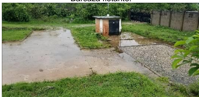
Lecho de lodos – Desarenadores.
