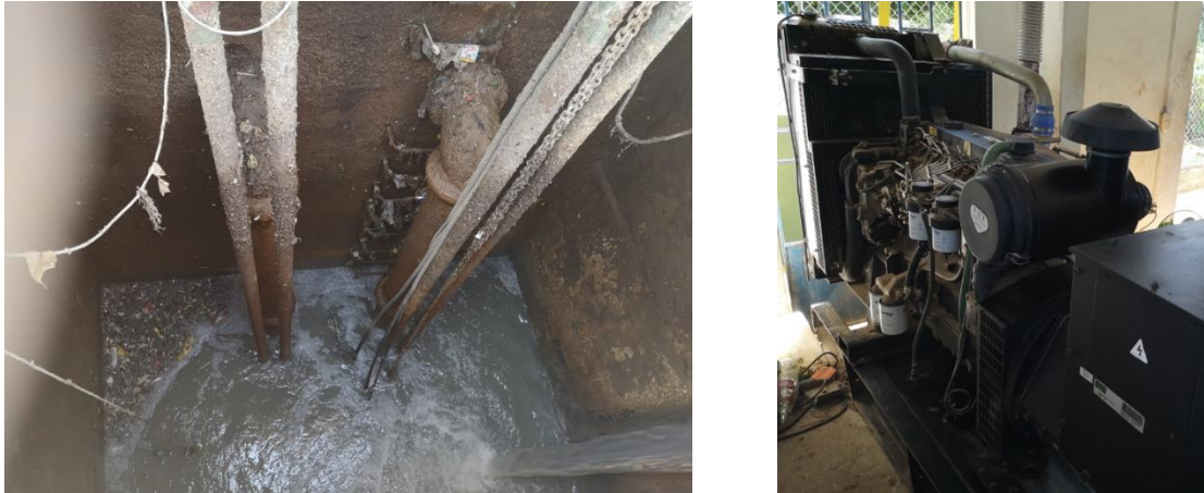
Imagen 13. Estación de bombeo
