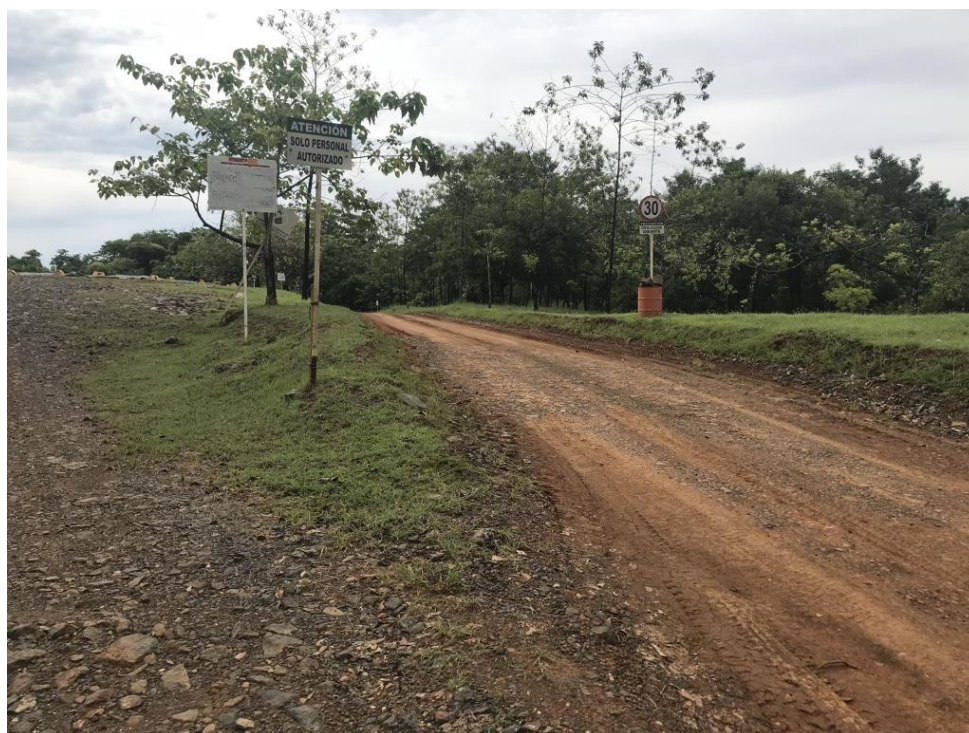
Foto 22 Vías internas relleno sanitario
