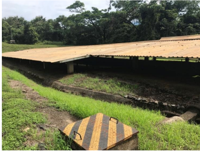
Foto 33 Piscinas de lixiviados
