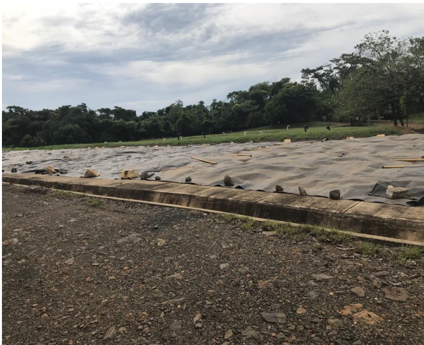
Foto 31 Trinchera actual con residuos cubiertos
