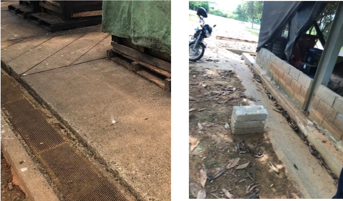
Foto 18 Canales de conducción de aguas lluvias
