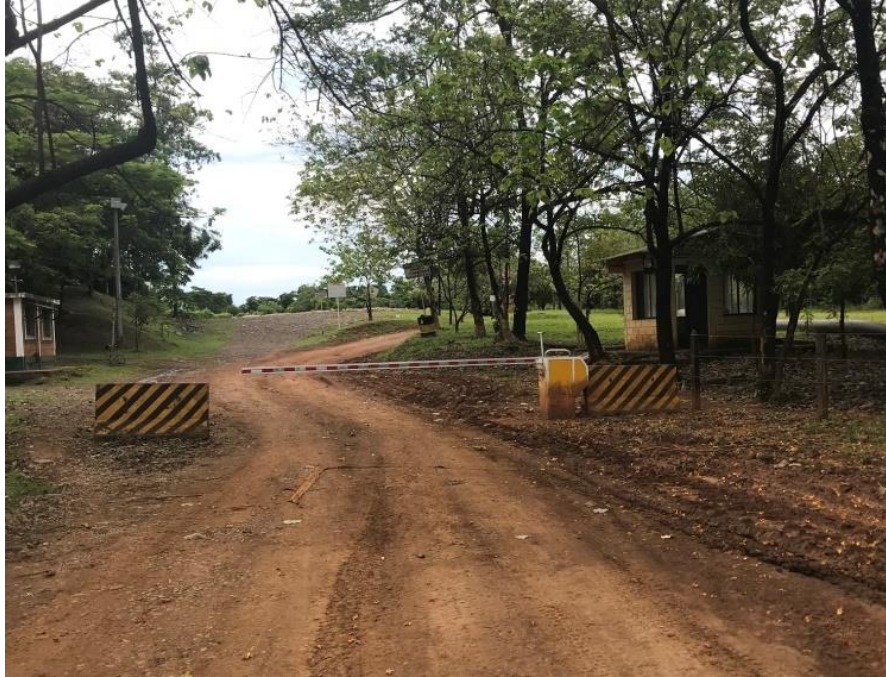
Foto 24 Talanquera de acceso vehicular y caseta de seguridad
