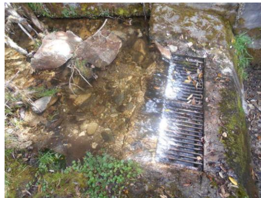
Imagen 12. Estructura de captación
