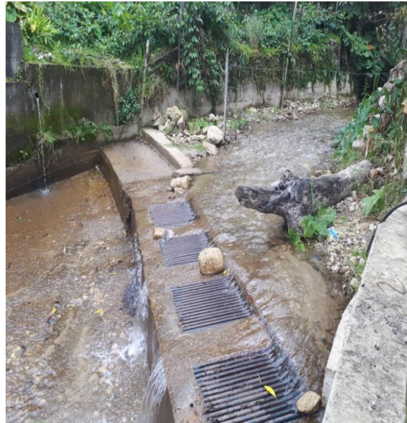
Imagen 5. Estructura de captación Quebrada Rosal y Cariongo.
