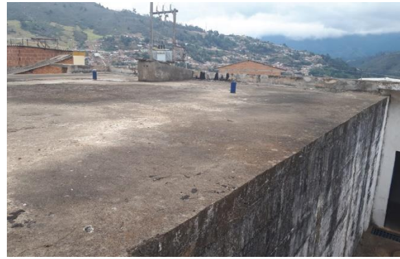
Tanque Santa Marta
