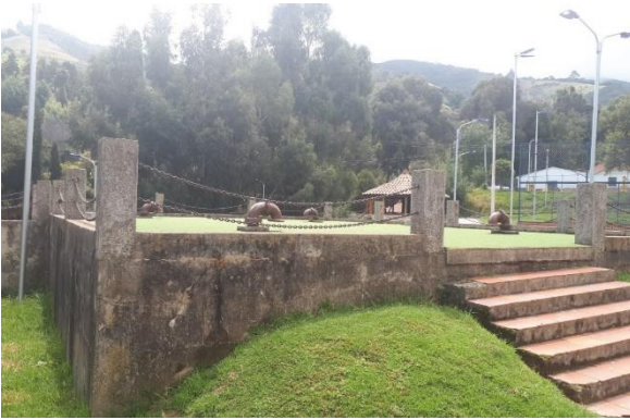
Tanque Los Tanques
