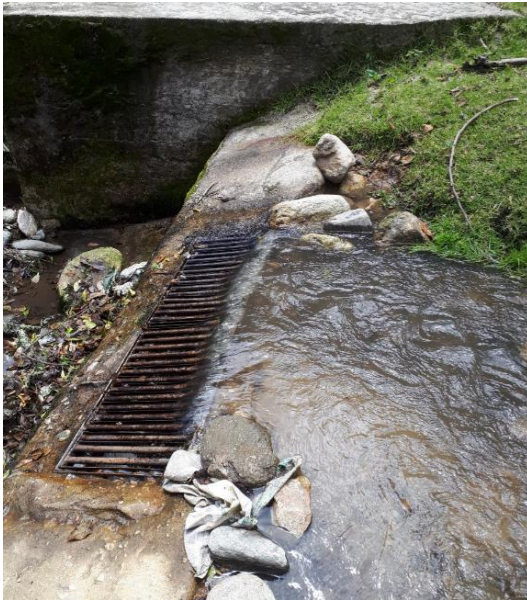
Imagen 5. Estructura de captación Quebrada Rosal y Cariongo.
