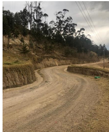
Imagen 49. Vías internas relleno
