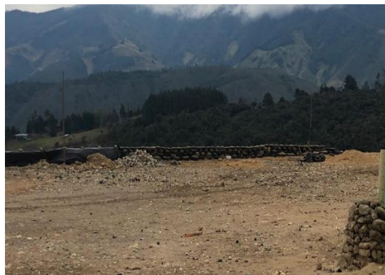
Imagen 55. Contención en las terrazas.
