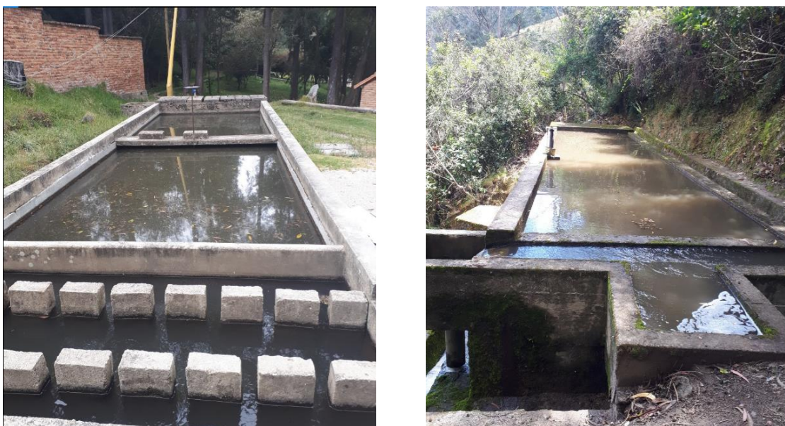
Imagen 6. Desarenadores Quebrada Cariongo y Rosal
