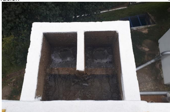
Transporte a filtros
