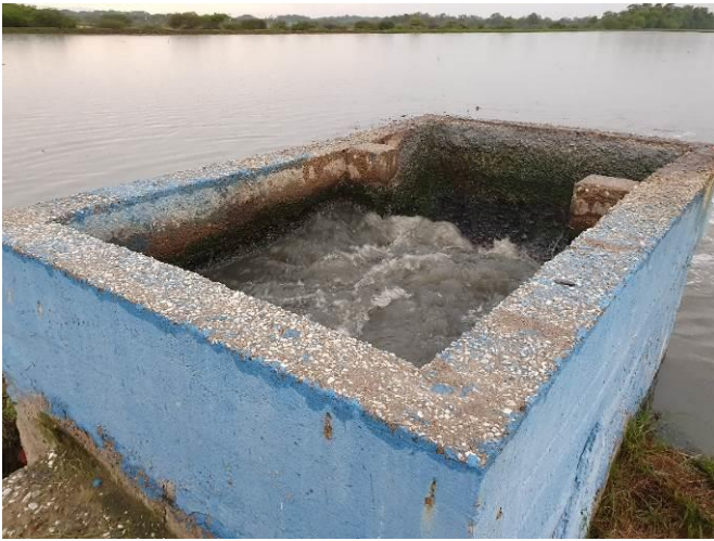
Cámara de entrada
