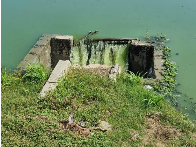
Estructura de salida
