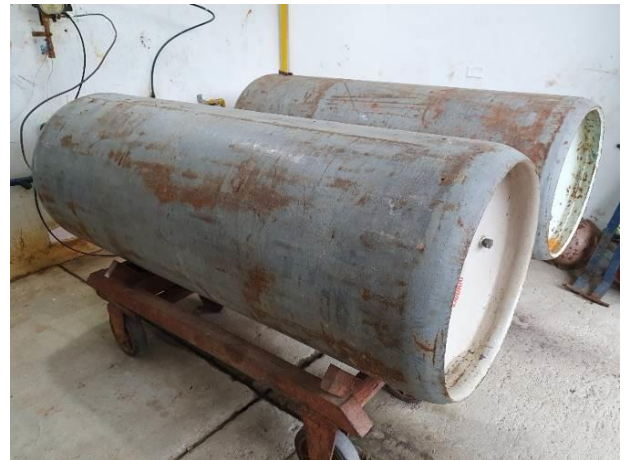
Tanques de cloro gaseoso
