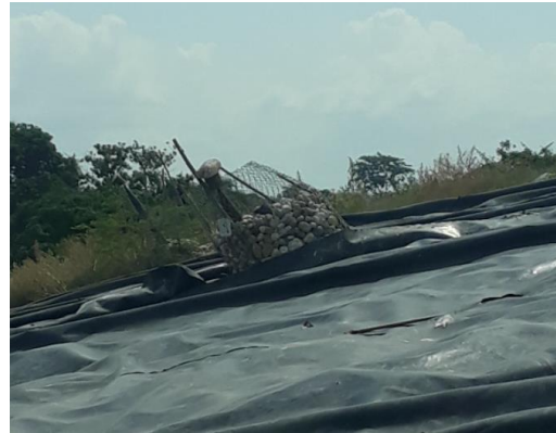
Imagen 66. Falta de posición vertical en chimeneas instaladas en Vaso 1
