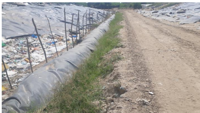
Imagen 69. Generación Cárcavas Celda3 Costado Noroccidental
