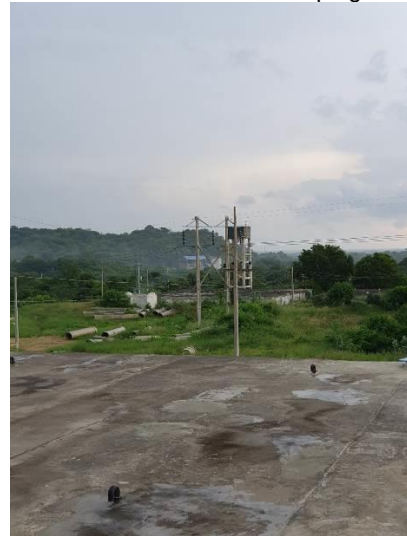
Tanques distribución Cordobita II e industrias
