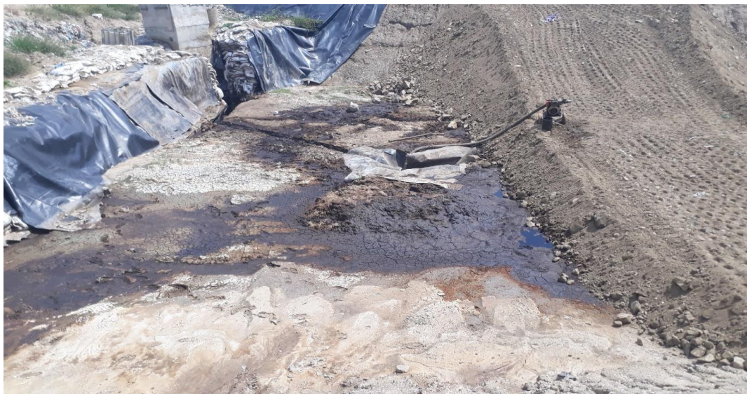
Imagen 65. Contacto directo de los lixiviados generados en el vaso 1 con el suelo
