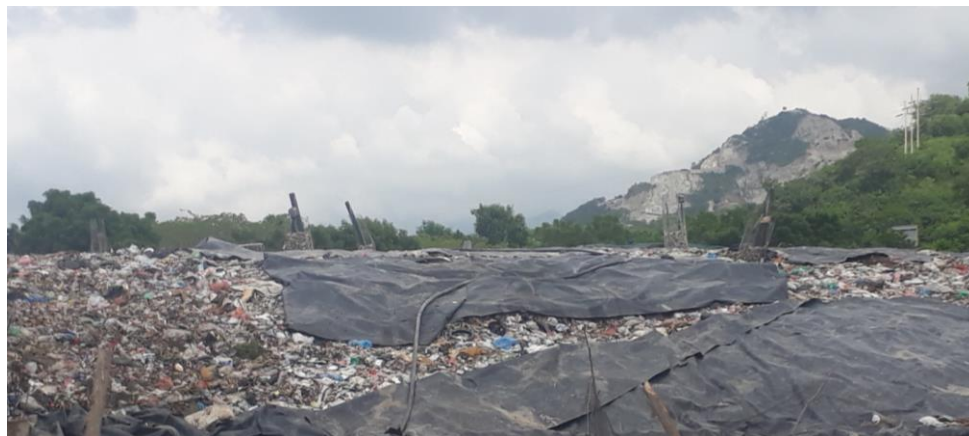
Imagen 67. Falta de posición vertical en chimeneas instaladas en Vaso 2
