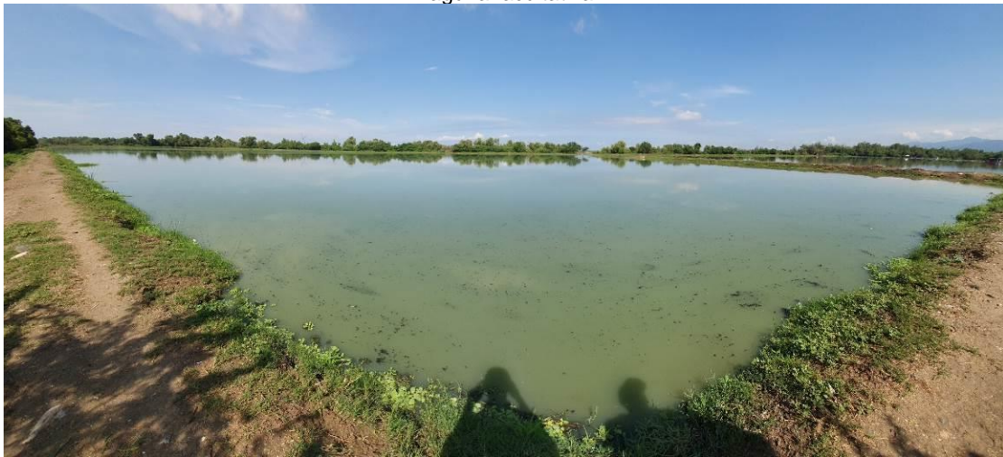
Laguna de maduración
