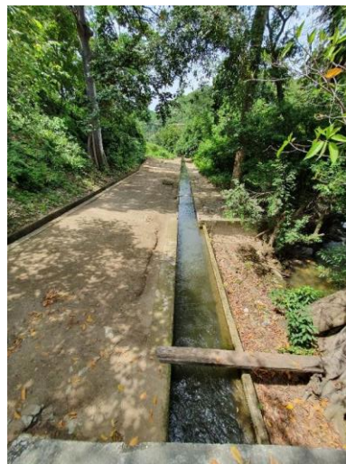
Canal de aducción
