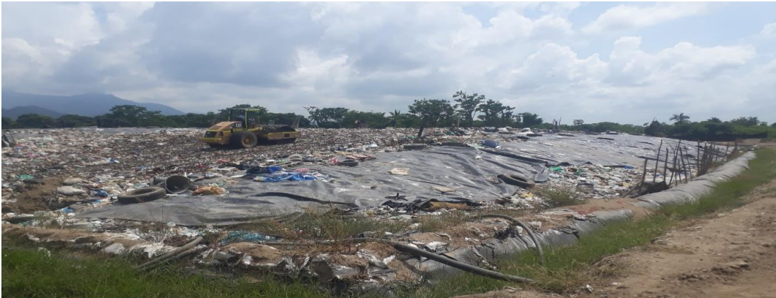
Imagen 58. Frente de trabajo actual, Vaso 2, Relleno Sanitario La María
