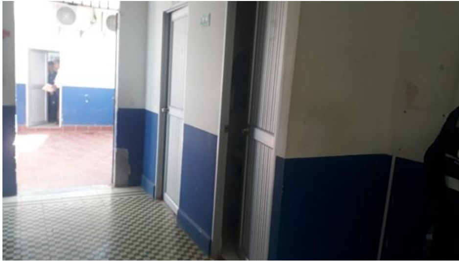
Imagen 45. Baños base de operaciones
