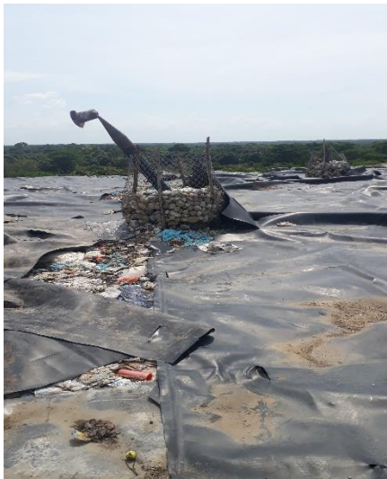
Imagen 67. Falta de posición vertical en chimeneas instaladas en Vaso 2
