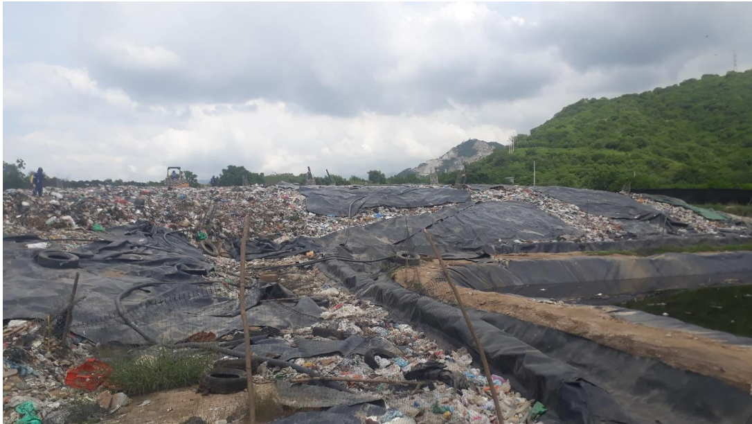
Imagen 61. Falta de cobertura de residuos sólidos costado sur Vaso 2
