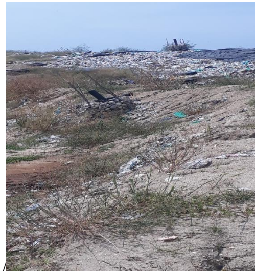
Imagen 67. Falta de posición vertical en chimeneas instaladas en Vaso 2
