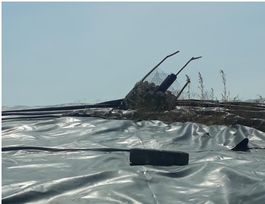
Imagen 66. Falta de posición vertical en chimeneas instaladas en Vaso 1
