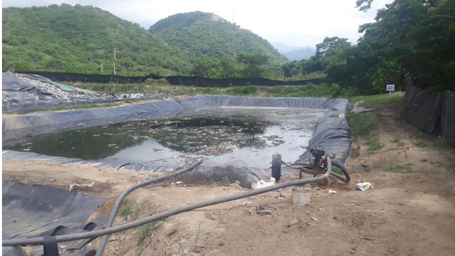
Imagen 63. Pondaje 3 y bomba de recirculación lixiviados
