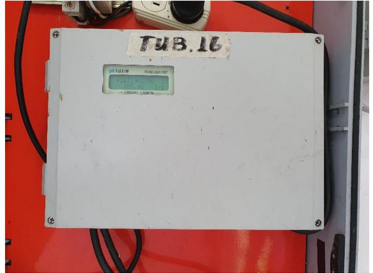
Macromedición de la tubería de 16 pulgadas
