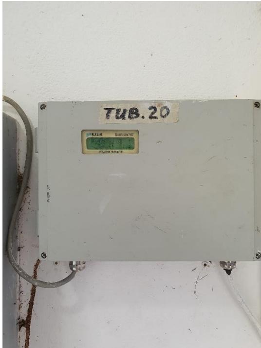
Macromedición de la tubería de 20 pulgadas
