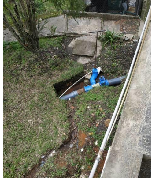
Interconexión a llegada planta
