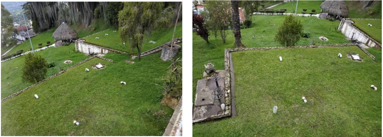
Imagen 12. Tanque de almacenamiento del sistema de acueducto
