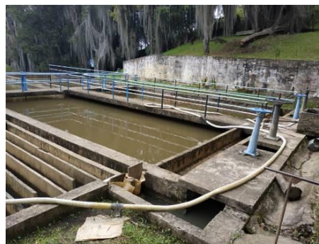
Sistema de sedimentadores
