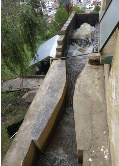
Cámara de llegada a la planta y canaleta Parshall
