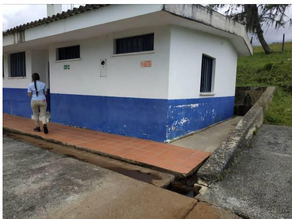
Caseta de Bombeo
