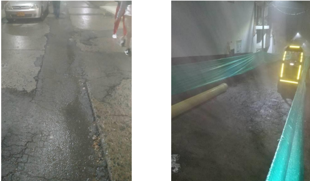
Imagen 22. Instalación de las nuevas redes sistema de alcantarillado
