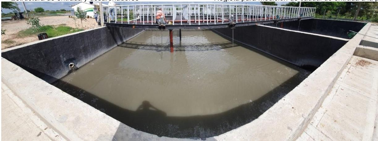
Tanque de homogenización
