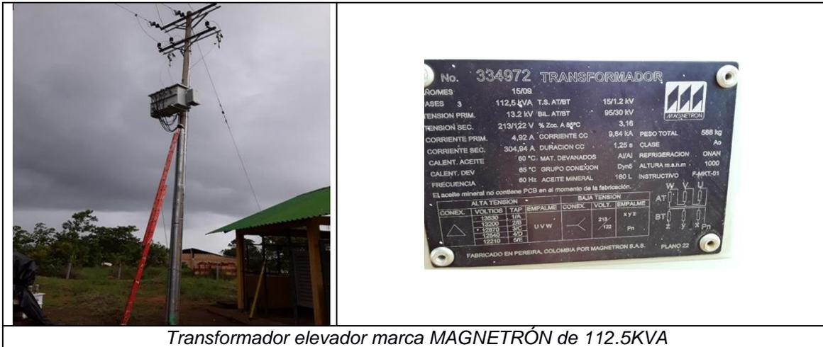
Transformador elevador marca MAGNETRÓN de 112.5KVA
