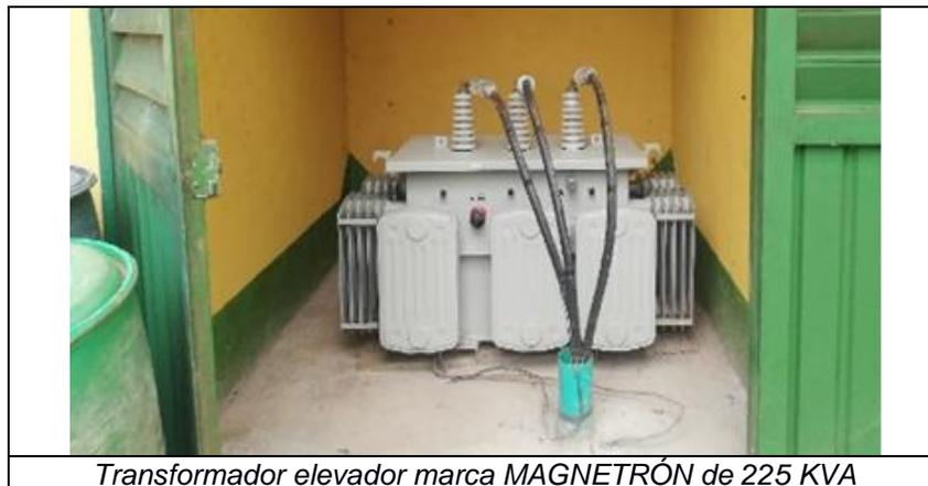
Transformador elevador marca MAGNETRÓN de 225 KVA
