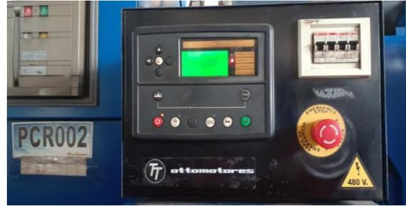
*Equipo PCR 002 - Grupo Electrónico CUMMINS QST – 30 G4 de 1200 kW Puerto Carreño (En operación)*
