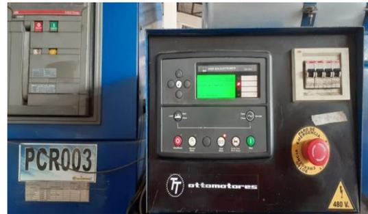
*Equipo PCR 003 - Grupo Electrónico CUMMINS QST – 30 G4 de 1200 kW Puerto Carreño (En operación)*
