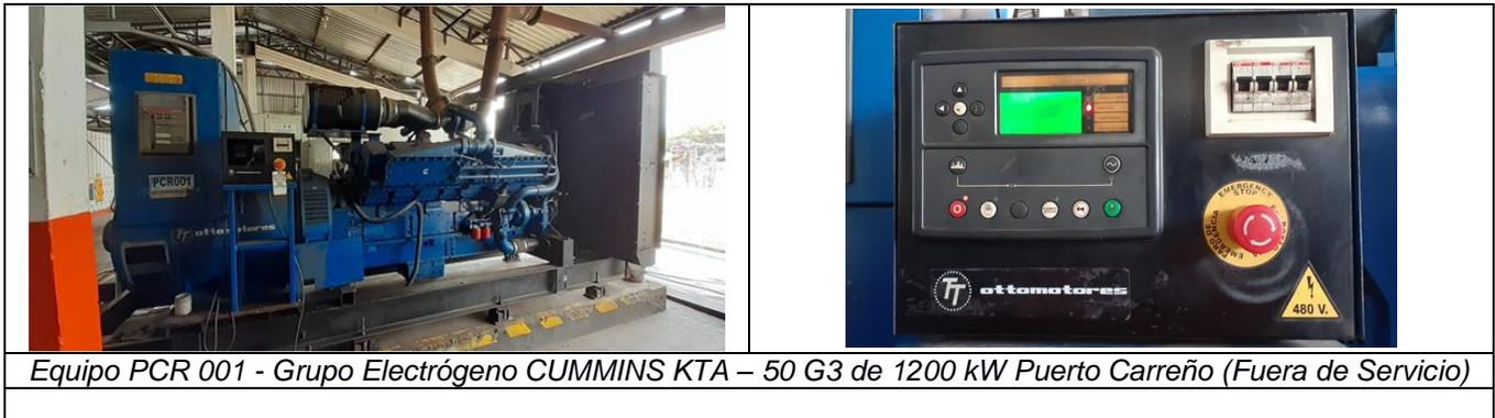
Equipo PCR 001 - Grupo Electrónico CUMMINS KTA – 50 G3 de 1200 kW Puerto Carreño (Fuera de Servicio)
