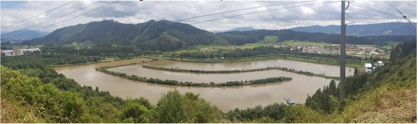
Dársena de presedimentación (Vista desde la PTAP Tibitoc)
