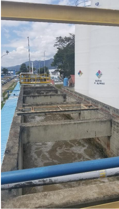
Canal de aducción
