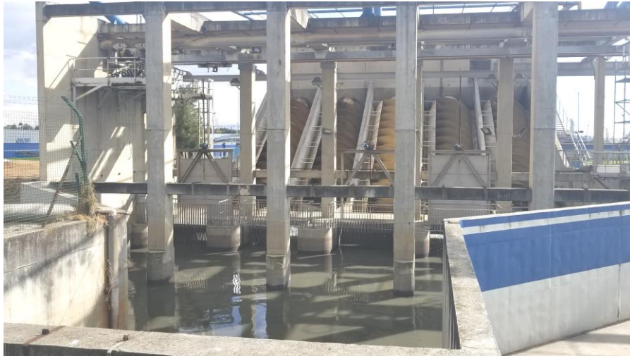
Tornillos de Arquímedes
