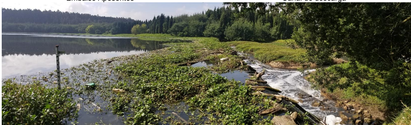
Estructura de rebose del embalse
