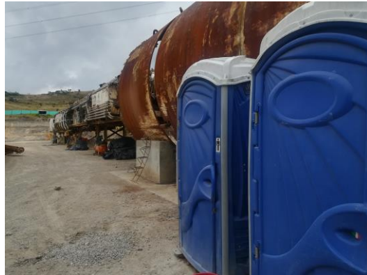
Pozo de Conexión – Extracción (Antiguo pozo ITC 12). Máquinas tuneladoras en proceso de desmontaje.
