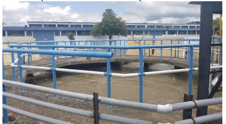
Estructura de reparto (Pulpo)
