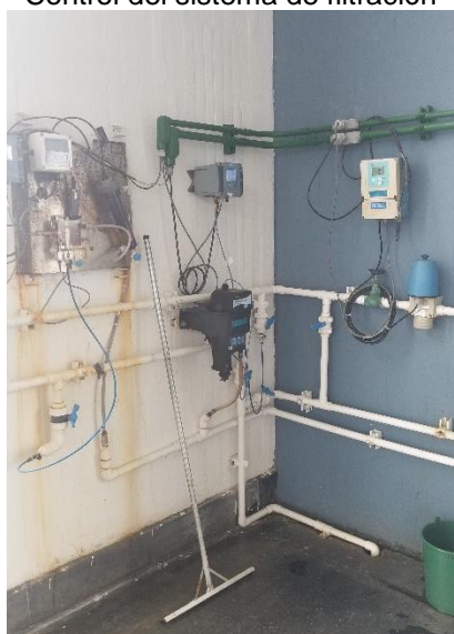
Medición en línea de calidad del agua tratada
