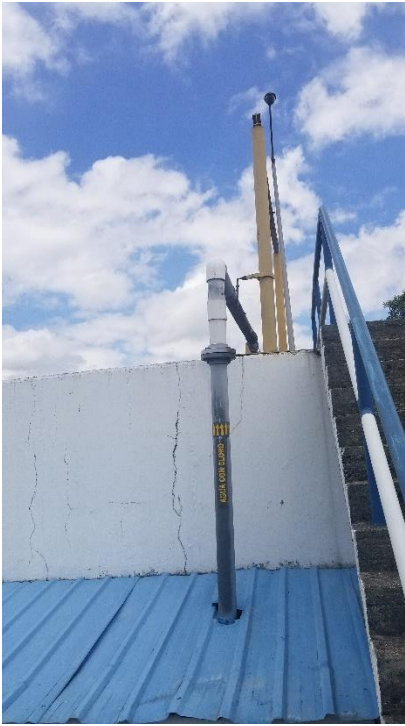
Aplicación de agua con cloro
