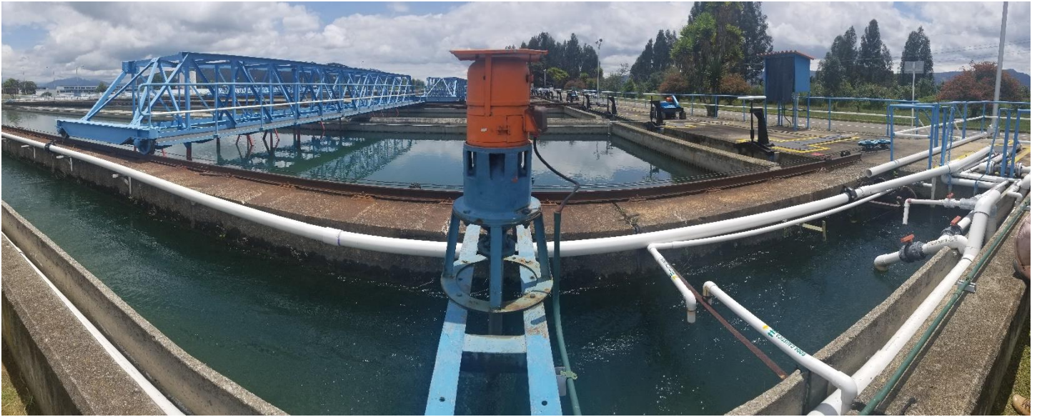
Canal de agua clarificada
