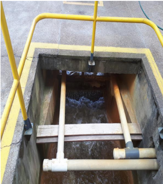
Dosificación de Coagulante
