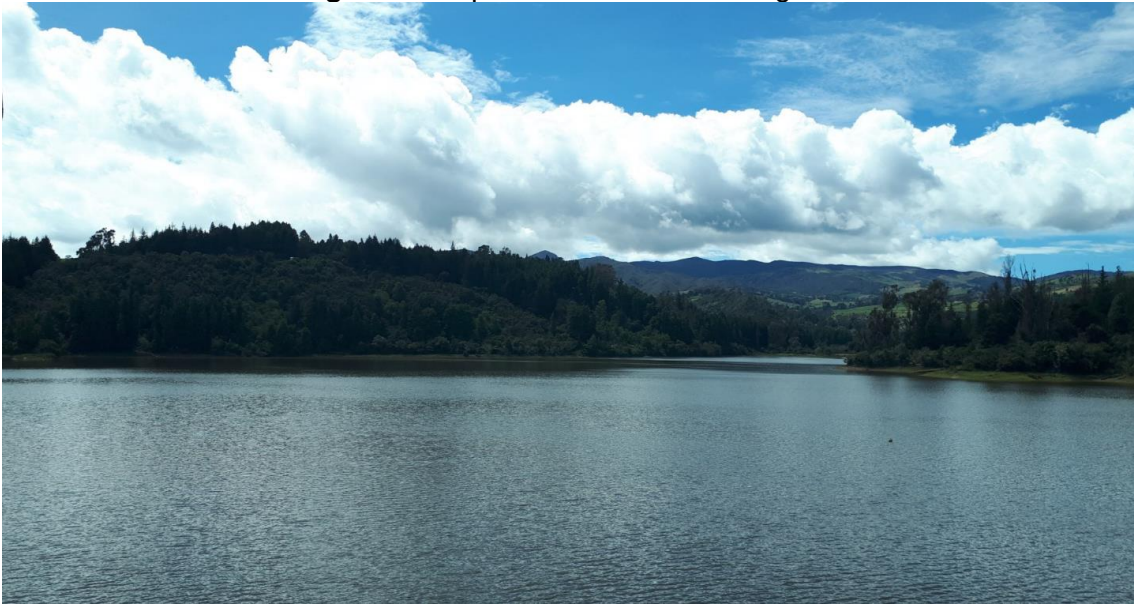
Captación Embalse La Regadera
