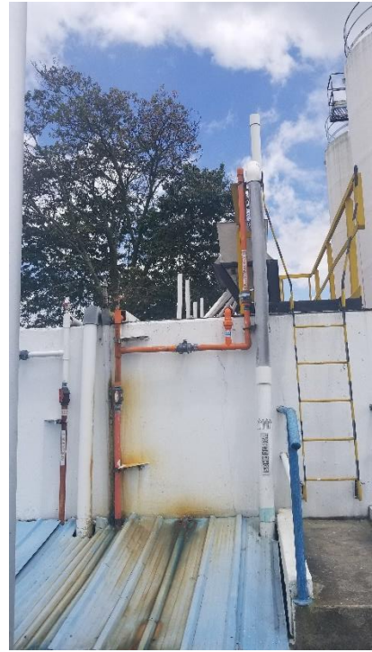
Aplicación de cloruro férrico y leche de cal
