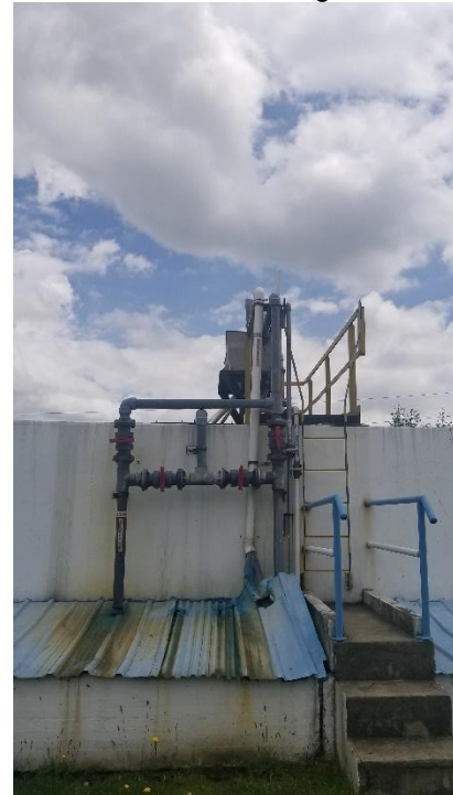
Aplicación de sulfato de aluminio
