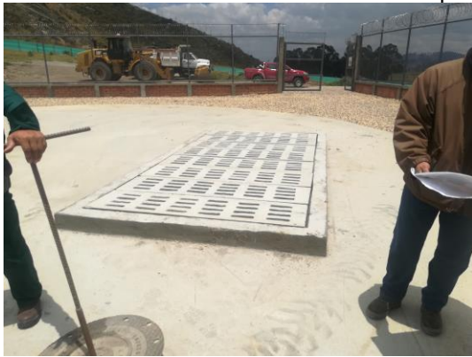
Pozo de Conexión – Extracción (Antiguo pozo ITC 12). Punto de conexión entre el Interceptor Tunjuelo - Canoas con Túnel de Emergencia
