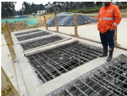
ITC 1 Pozo inicio Interceptor Tunjuelo - Canoas
