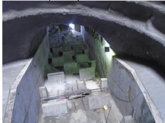
Pozo de Conexión – Extracción (antiguo pozo ITC 12). Base del Pozo – Estructura de disipación de energía del flujo de Aguas Residuales (Tunjuelo - Canoas y Túnel de Emergencia). Fuente EAAB.
