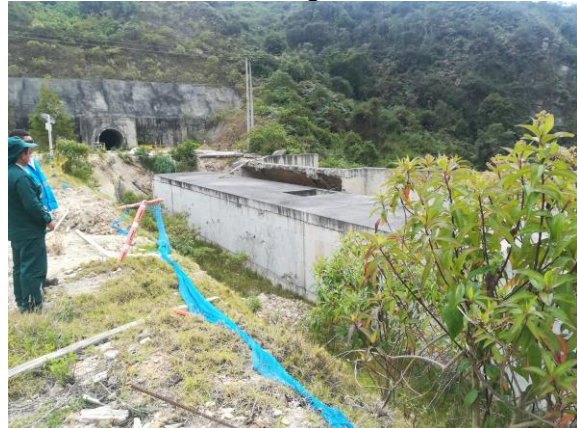
Estructura de disposición final y vertimiento del túnel de emergencia al río Bogotá.
