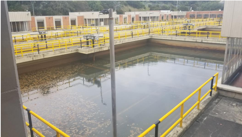
Línea 1 de Filtros
