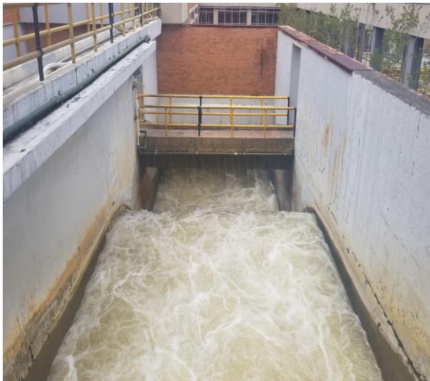
Resalto hidráulico – dosificación de Coagulante
