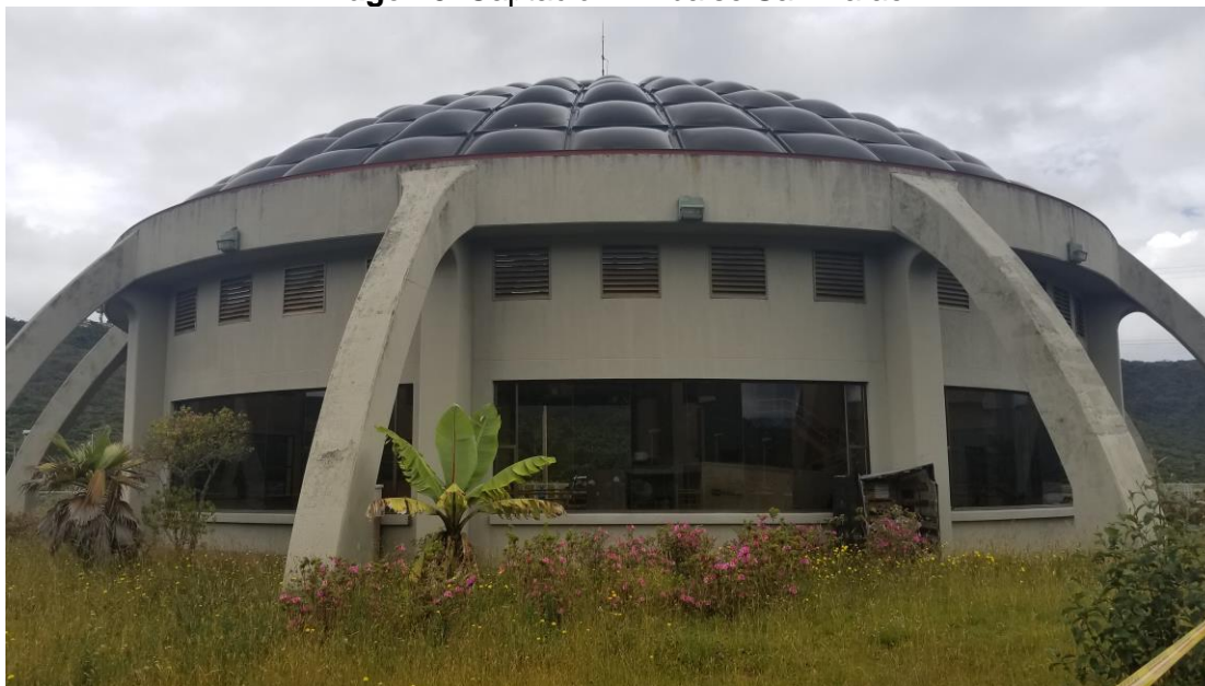
Estación de bombeo Embalse San Rafael
