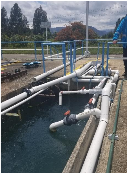
Sistema de aplicación de soda cáustica y/o leche de cal para control de manganeso
