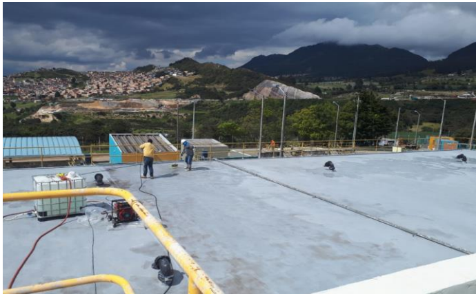
Tanque de almacenamiento
