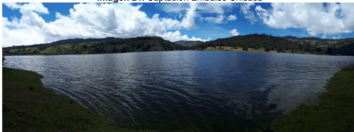
Captación Embalse Chisacá
