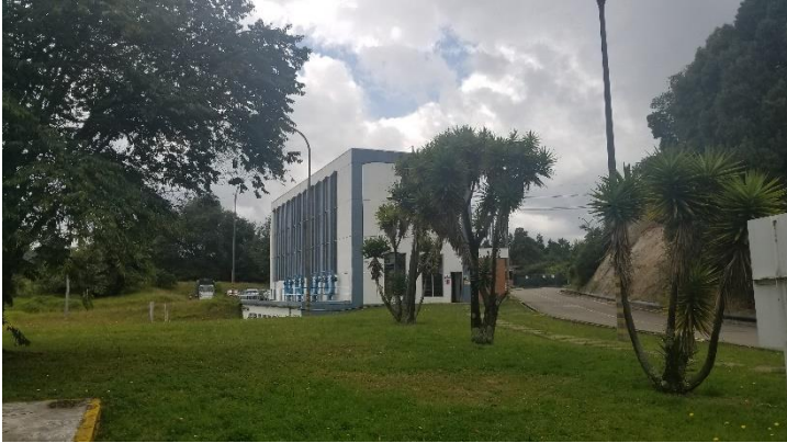
Estación de bombeo No. 2.
