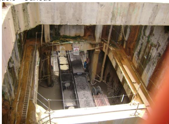
ITC 8 – 8A Pozo de lanzamiento de Máquinas tuneladoras – Futuro punto de conexión área de expansión de Soacha (visita SSPD Agosto 2012)
