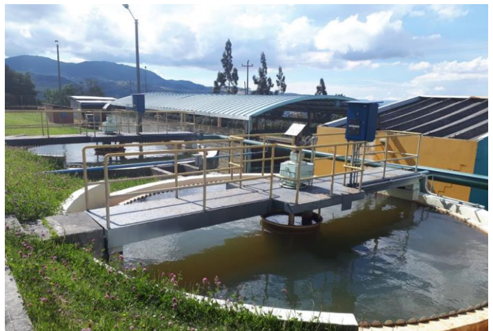
Tanques Espesadores
