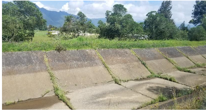
Canal de aducción a la dársena de presedimentación
