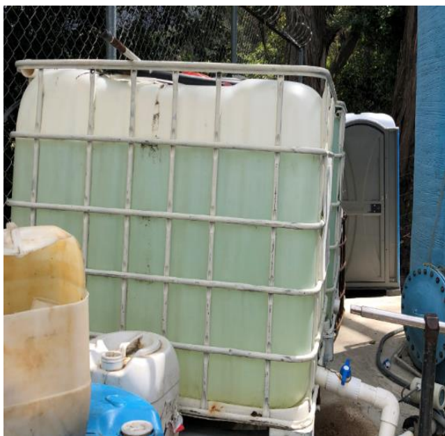
Aplicación de químicos
