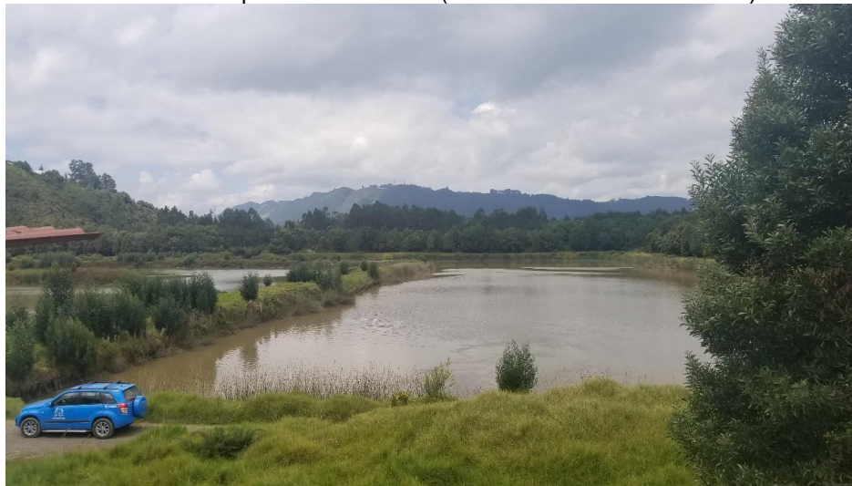
Ingreso de agua a la dársena
