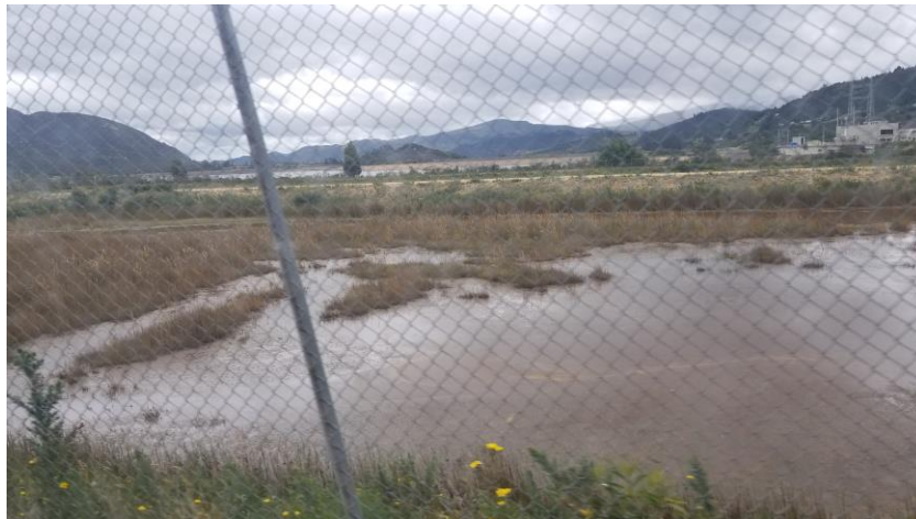
Laguna de secado lodos resultantes del proceso de potabilización Fuente: Registro fotográfico SSPD – visita octubre de 2018
