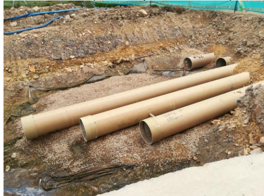
ITC 1 Pozo inicio Interceptor Tunjuelo – Canoas. Instalación de tubería de descarga de aguas residuales al río Tunjuelo antes de la desembocadura del río Bogotá
