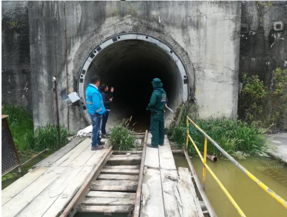
Punto final del Túnel de Emergencia en la zona denominada El Charquito – Soacha. Diámetro del túnel de 3,2 m
