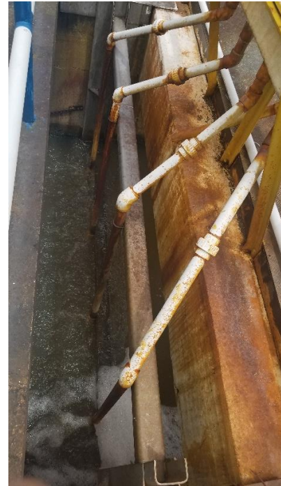
Dosificación de coagulante
