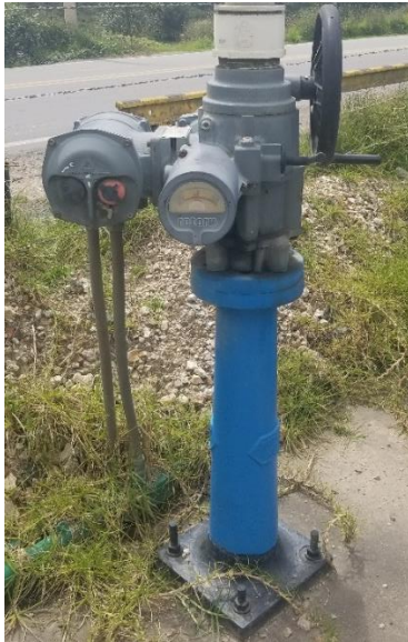
Válvula electromecánica
