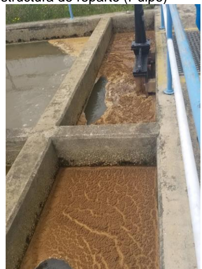
Estructura de reparto (Pulpo)
