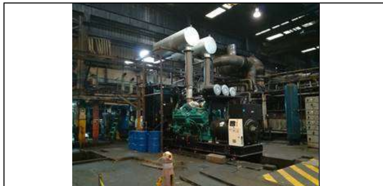
Motogenerador CUMMINS 201 – 2 MW en instalación. Fuente: Visita DTGE. Octubre 2018.
