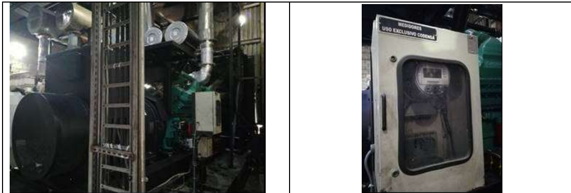
Motogenerador CUMMINS 801 – 2 MW
