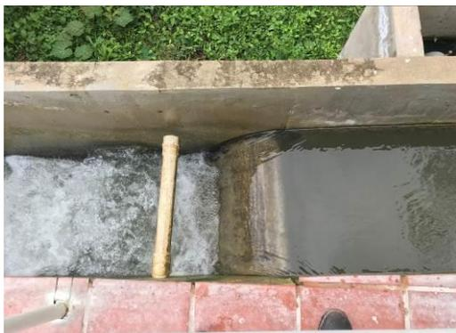
Adición del coagulante – Resalto Hidráulico
