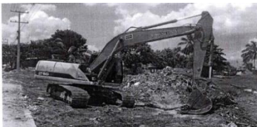
Imagen 9. Limpieza punto crítico Barrio el Pasito
