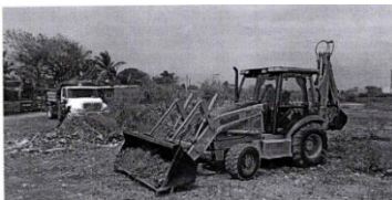
Imagen 10. Limpieza Punto Crítico Barrio Mesolandia
