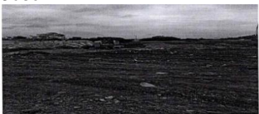
Imagen 12. Limpieza Punto Crítico Cancha 5x10 Barrio San José
