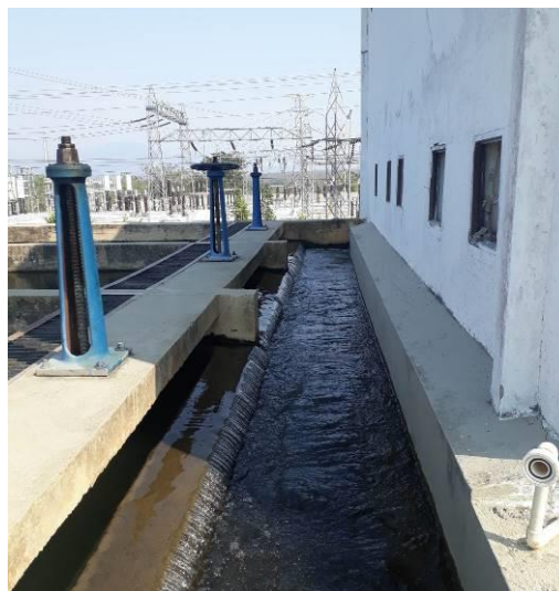
Canal salida desarenadores
