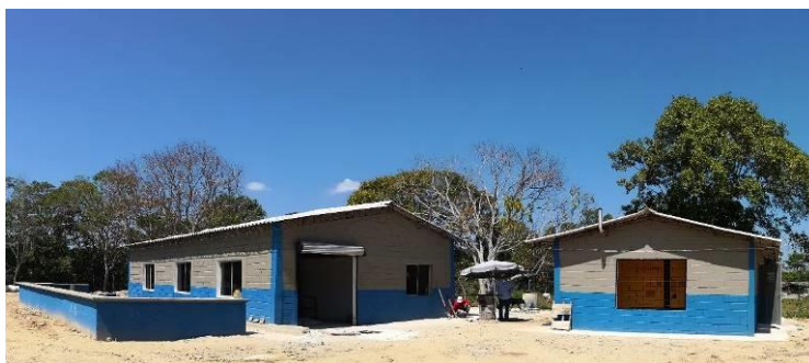
Imagen 19. Estación de Bombeo de Agua Residual
