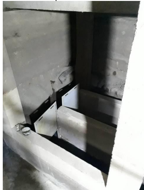
Canales de ingreso
