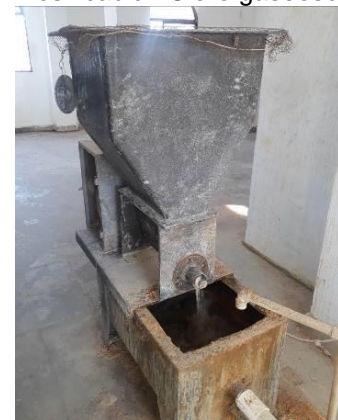
Tolva dosificadora de Sulfato
