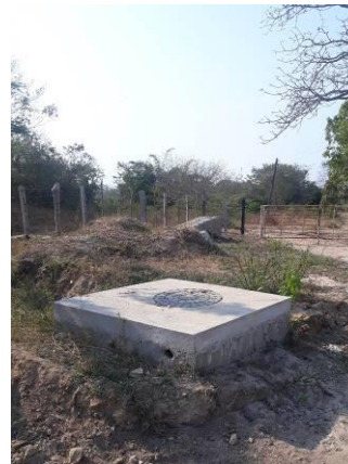
Canal de entrada de la aducción a la PTAP
