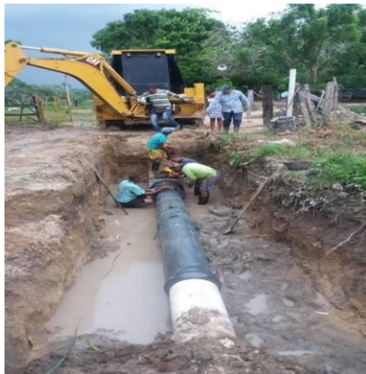
Obras ejecutadas en la aducción
