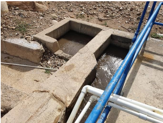
Cámara de entrada
