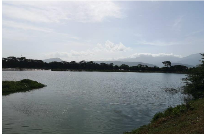
Imagen 48. Sistema de tratamiento de aguas residuales del municipio de Fonseca.
