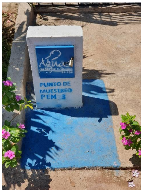
Imagen 46. Punto de muestreo de calidad del agua en la red de distribución.
