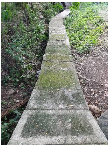
Canal de aducción
