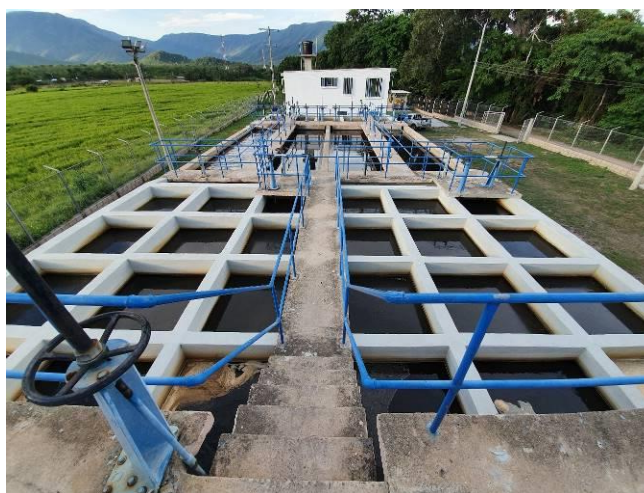
Vista general de la planta
