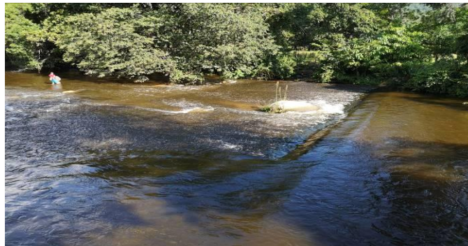
Imagen 20. Captación en el río Ranchería
