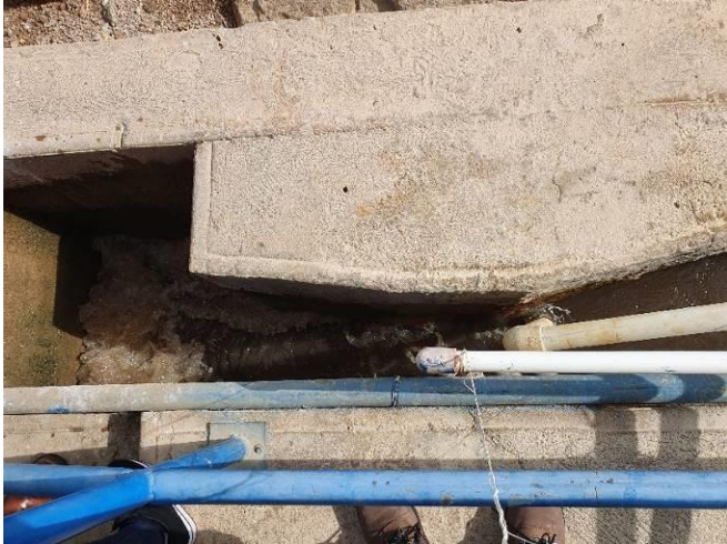
Aplicación de coagulante
