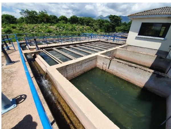
Vista general de la planta
