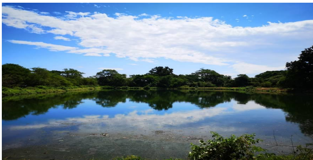
Imagen 47. Sistema de tratamiento de aguas residuales del municipio de El Molino
