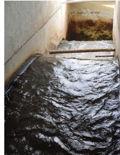
Aplicación de coagulante y mezcla rápida
