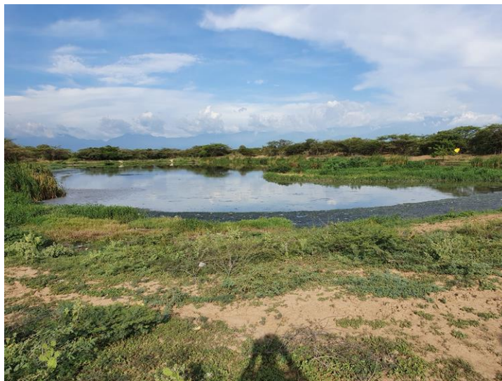
Imagen 50. Sistema de tratamiento de aguas residuales del municipio de San Juan del Cesar.
