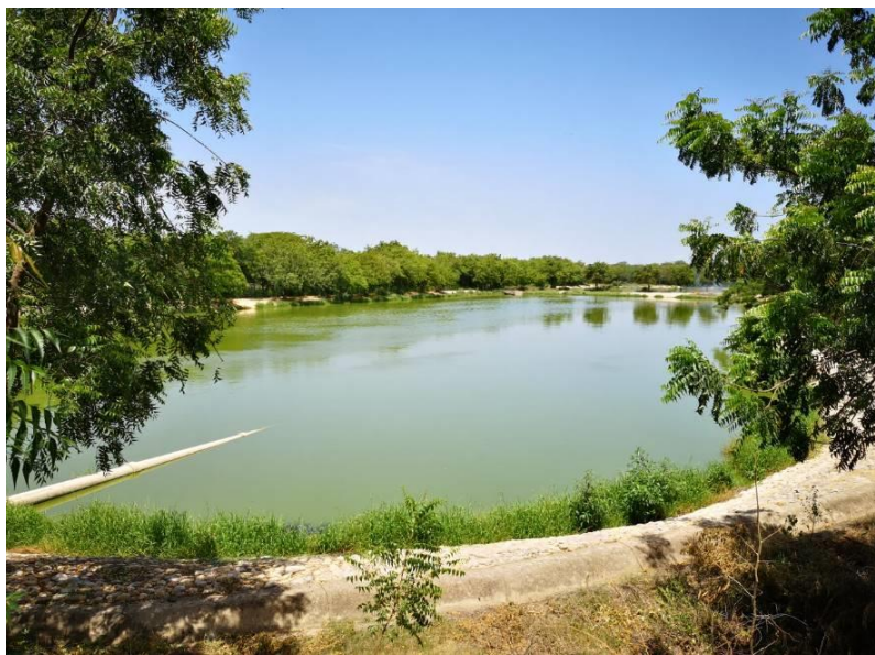
Imagen 49. Sistema de tratamiento de aguas residuales del municipio de Hatonuevo.
