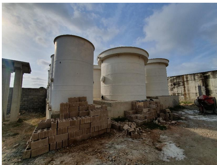
Obras proyecto de optimización PTAP
