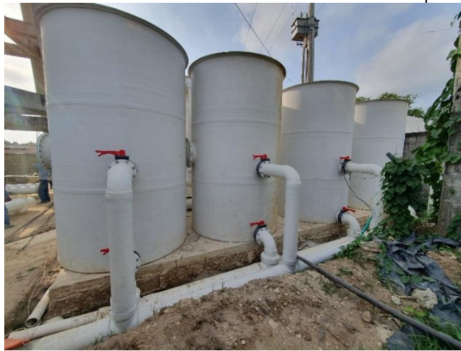
Obras proyecto de optimización PTAP
