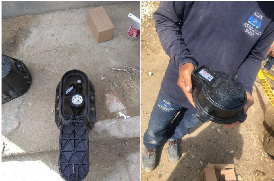
Imagen 34. Instalación de micromedidores
