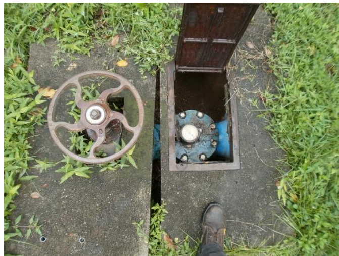
Imagen 16. Macromedidor salida de la PTAP
