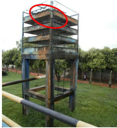
Imagen 11. Torres de aireación
