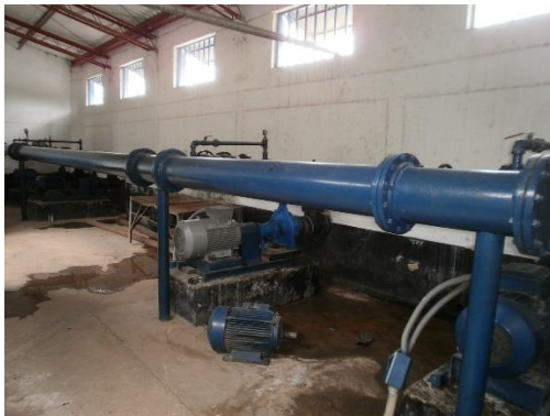
Imagen 15. Bombas centrifugas de distribución
