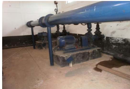
Imagen 15. Bombas centrifugas de distribución
