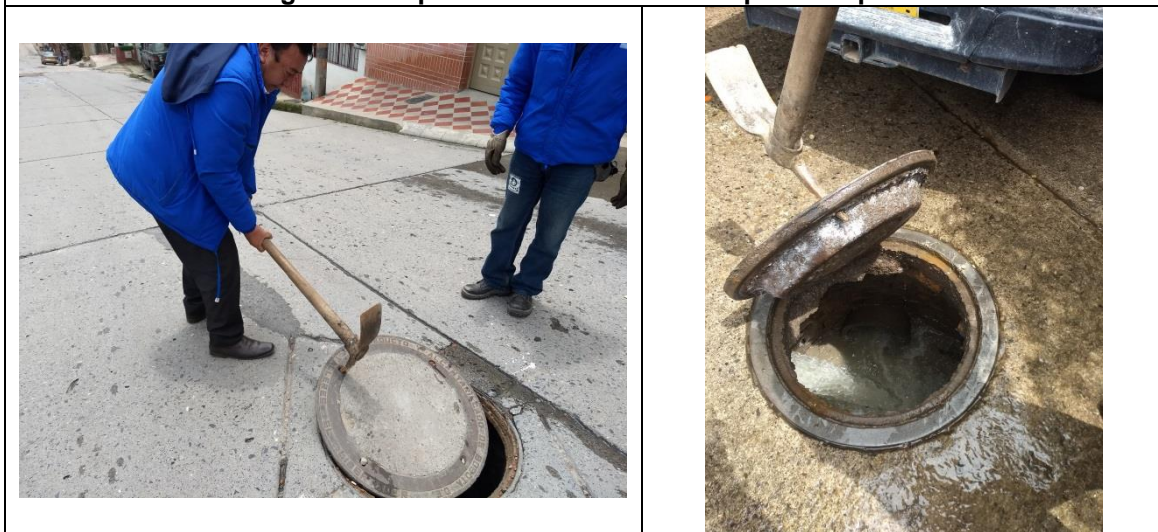
Imagen 42. Inspección visual Estado de pozos sépticos
