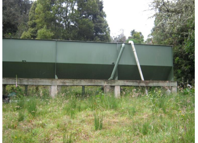
Imagen 14. Características Desarenador ubicado en la Bocatoma
