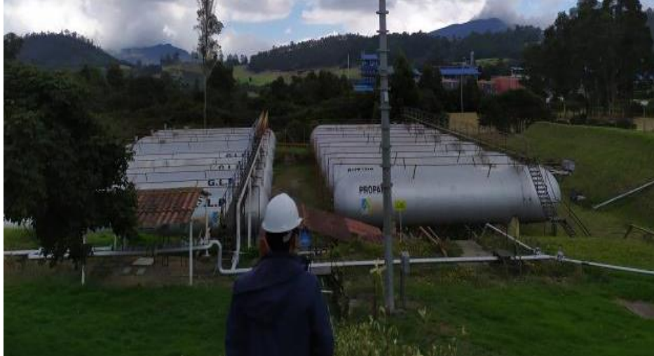
Imagen 8. Batería 3 de almacenamiento de GLP
