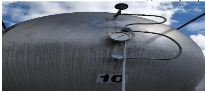
Imagen No. 10. Elementos de medición de nivel, presión y temperatura
