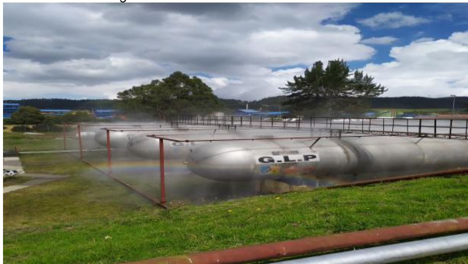
Imagen 8. Batería 3 de almacenamiento de GLP
