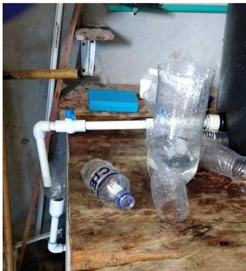
Imagen 14. Instrumentación dosificación desinfectante.
