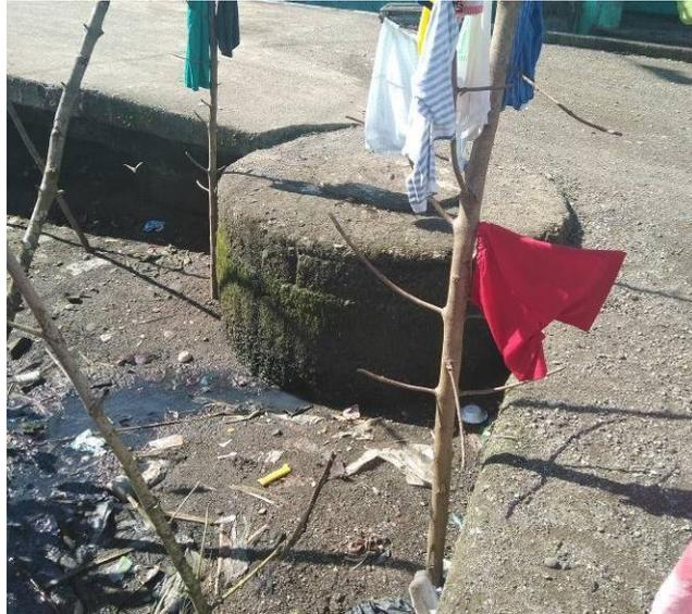
Imagen 25. Pozo de inspección con fuga sector Calle de la Virgen.
