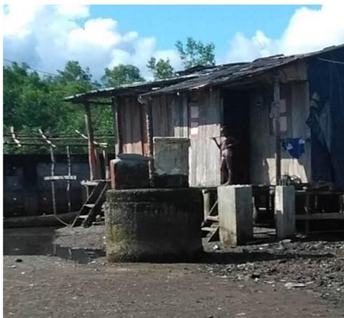
Imagen 23. Cámara de inspección por encima del nivel de la vía.
