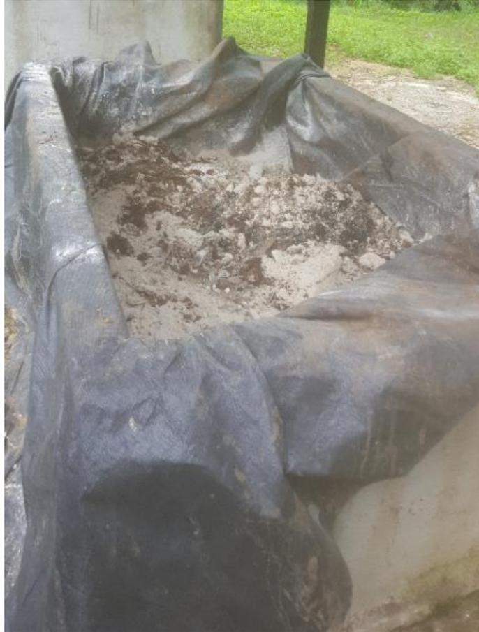
Ilustración 40. Lodos en deshidratación. Fuente: Visita de inspección y vigilancia del 02 y 03 de junio
