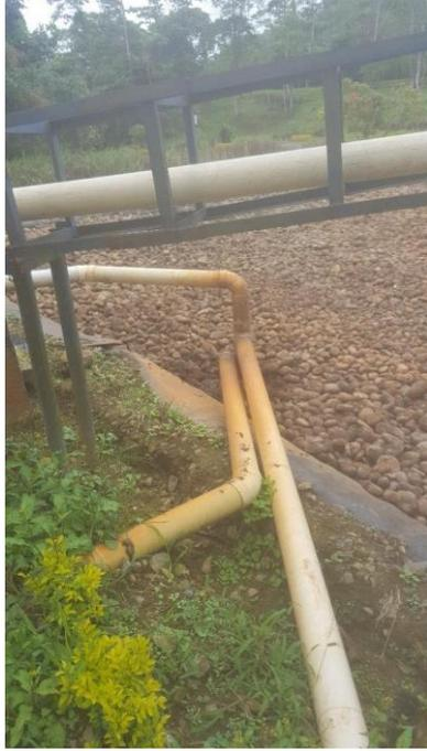
Ilustración 36. Unión de cauces de lixiviados. Fuente: Visita de inspección y vigilancia del 02 y 03 de junio
