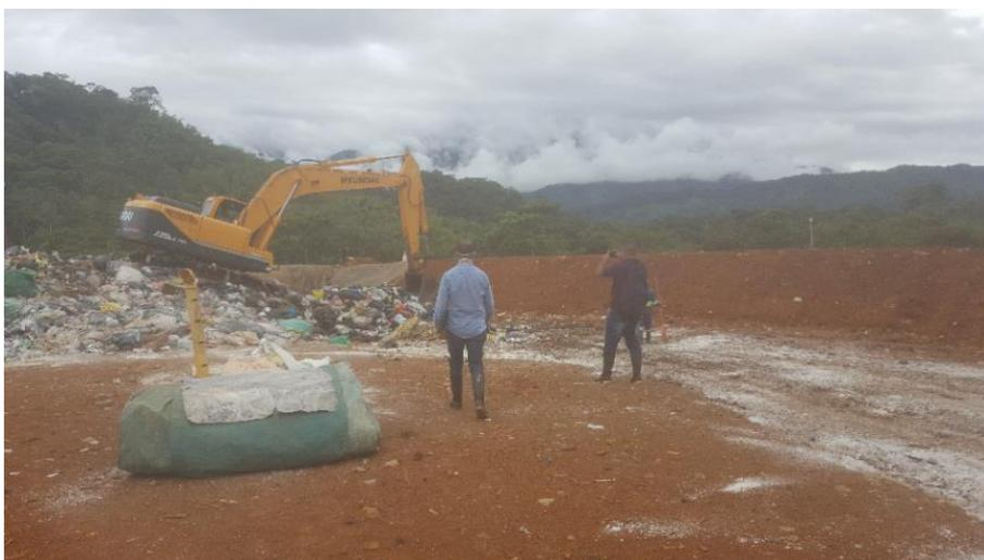
Ilustración 26. Retroexcavadora en labores de acomodación y disgregación de residuos. Fuente: Visita de inspección y vigilancia del 02 y 03 de junio de 2017
