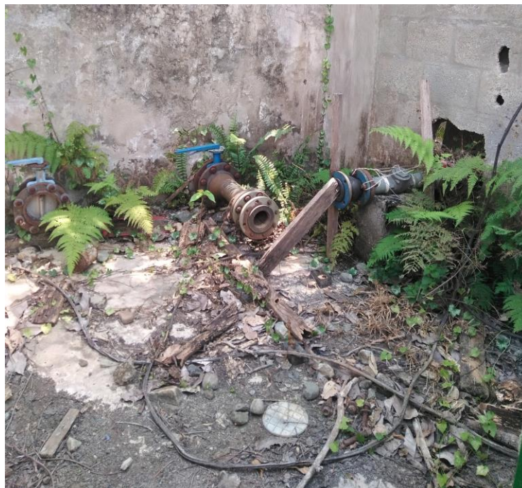
Imagen 32 Interior caseta ubicada en cercanías de la PTAP. Fuente: Visita SSPD, 2018.
