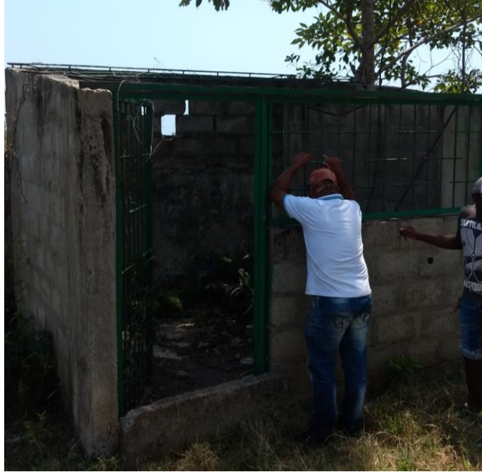
Imagen 31 Caseta ubicada al lado de la PTAP. Fuente: Visita SSPD, 2018.
