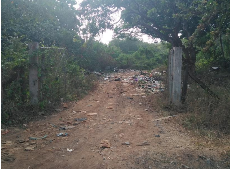
Imagen 57. Puerta de acceso al botadero a cielo abierto. Fuente: Visita SSPD 2018.
