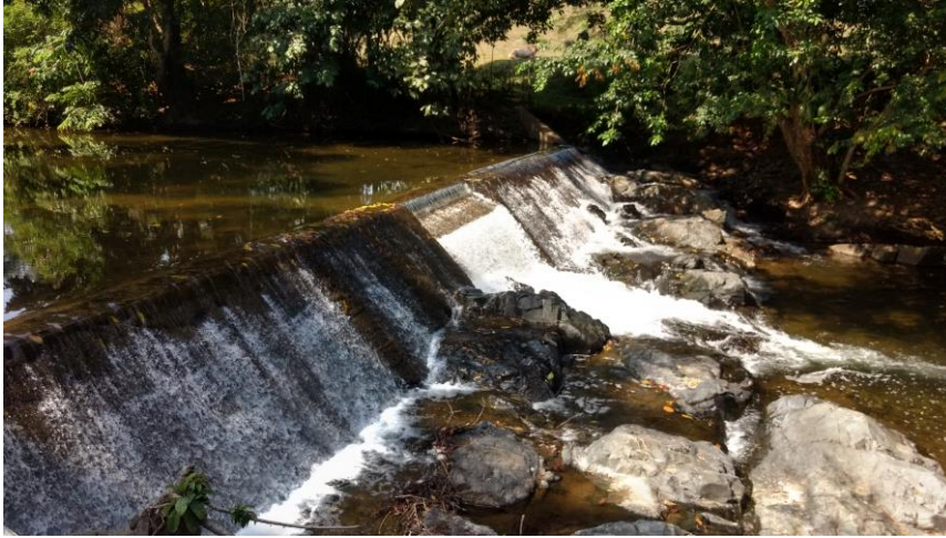
Imagen 13. Detalles de la bocatoma en la Captación Río Unguía. Fuente: Visita SSPD, 2018.
