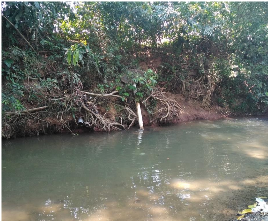
Imagen 28 Tubería con cambio de dirección. Fuente: Visita SSPD, 2018.
