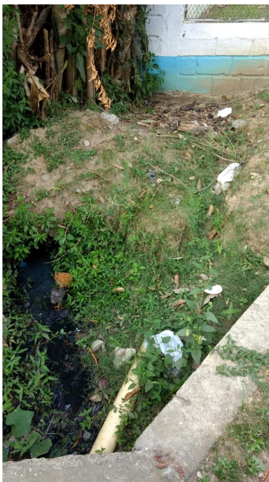
Imagen 40 Conexión vertimientos hospital. Fuente: Visita SSPD, 2018.
