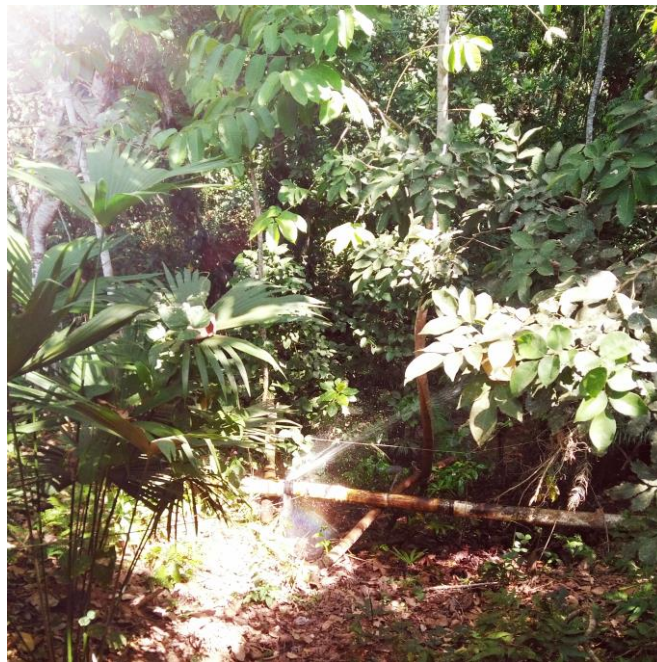
Imagen 17. Fuga de agua ubicada aproximadamente en el km 2. Fuente: Visita SSPD, 2018.
