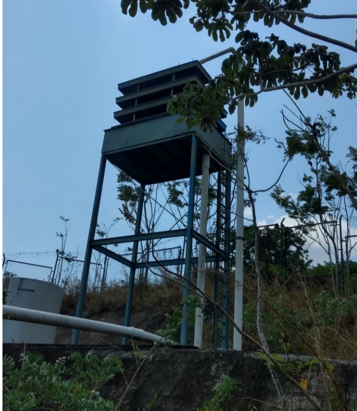
Imagen 23. Torre de aireación PTAP. Fuente: Visita SSPD, 2018.
