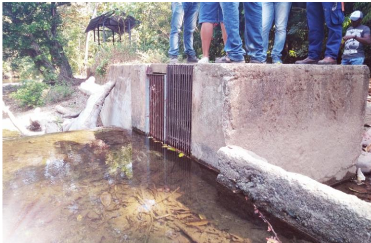
Imagen 14. Río Unguía, bocatoma. Fuente: Visita SSPD, 2018.
