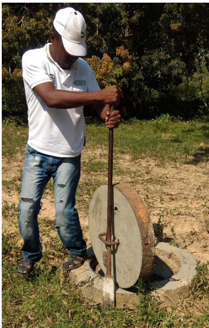
Imagen 42 Pozos de inspección. Fuente: Visita SSPD, 2018.
